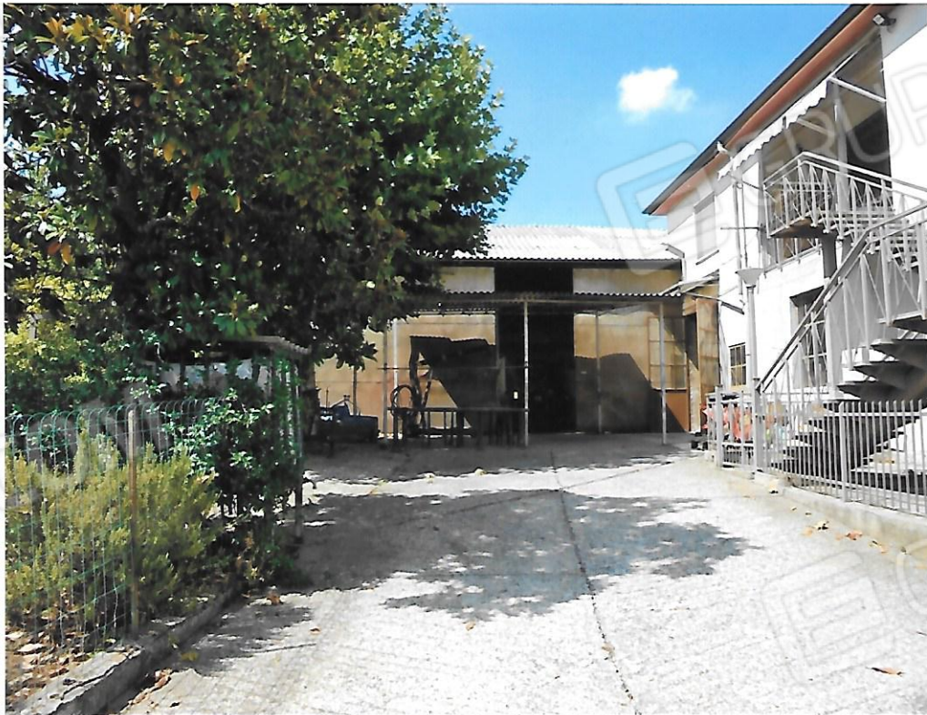
Foto 6 – Prospetto tettoia con avancorpo
