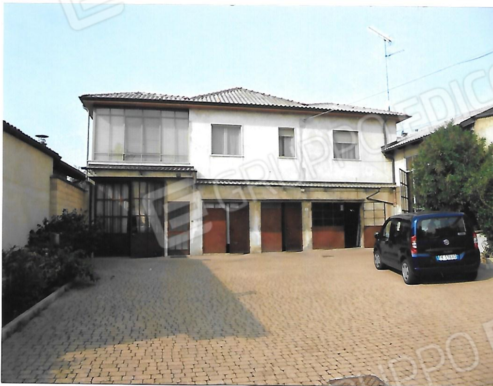
Foto 3 –Prospetto cortile da Via S.Lorenzo-solo Piano terra
