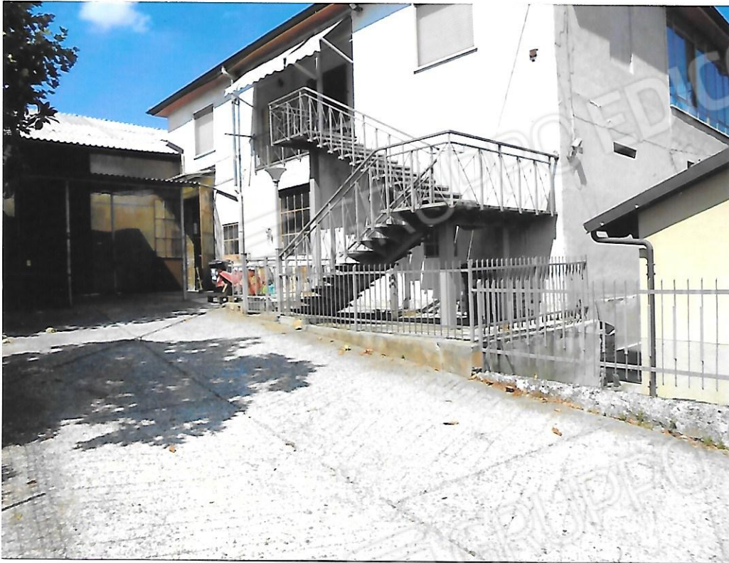
Foto 5- Fronte cortile su Prov.le-Solo piano terreno, con scala in ferro per accesso ad altrui proprietà
