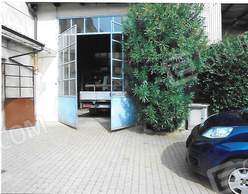
Foto 4 – Secondo prospetto da cortile su Via S.Lorenzo
