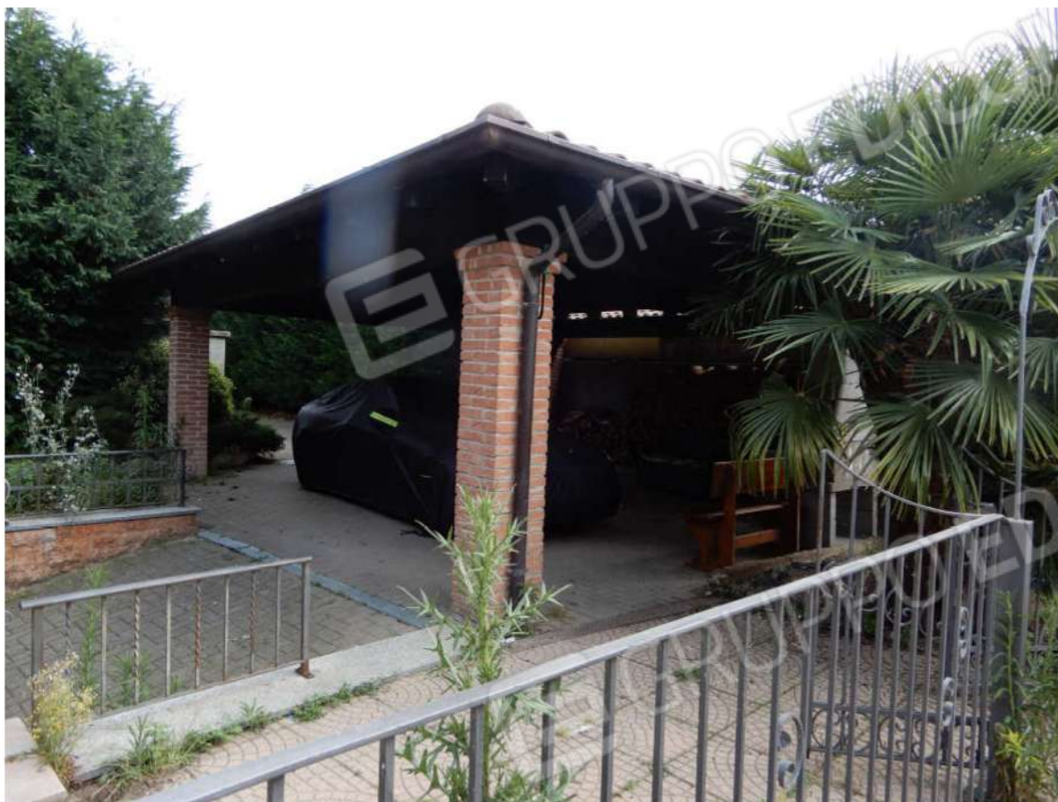
Tettoia posta al termine della via di accesso interna alla proprietà.
