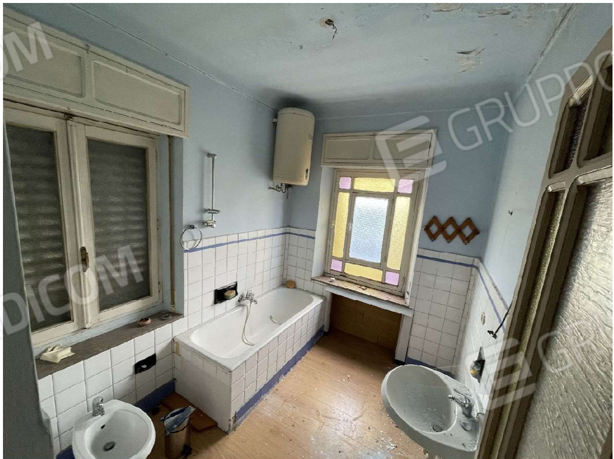
Bagno al piano primo
