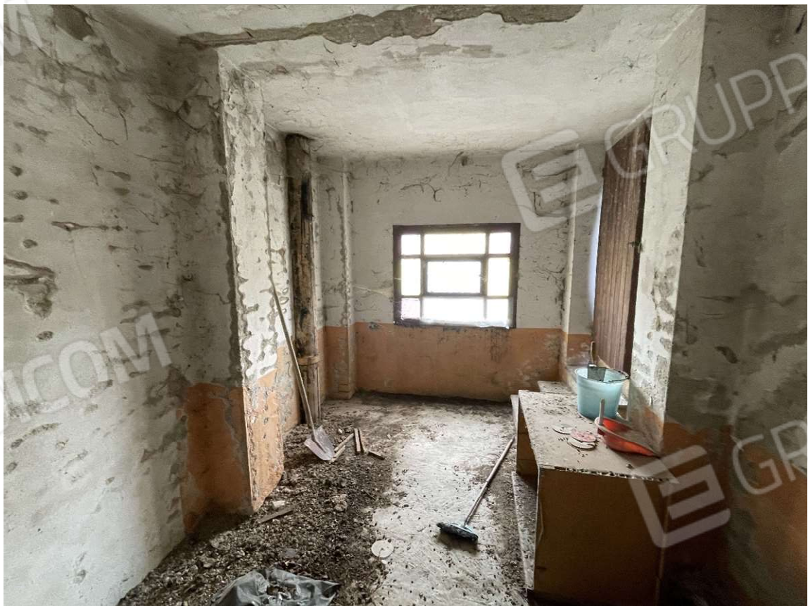
Locale ripostiglio al terzo piano
