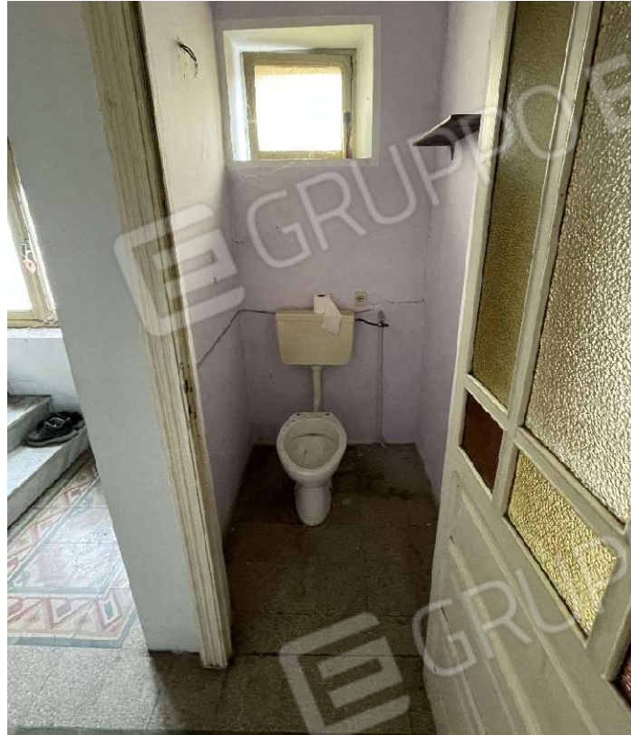
Wc al piano primo
