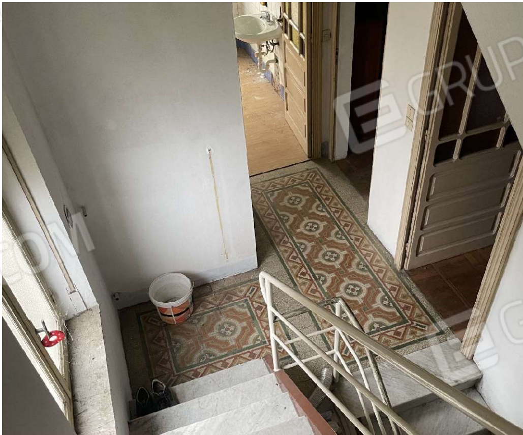
Vista del disimpegno al piano primo
