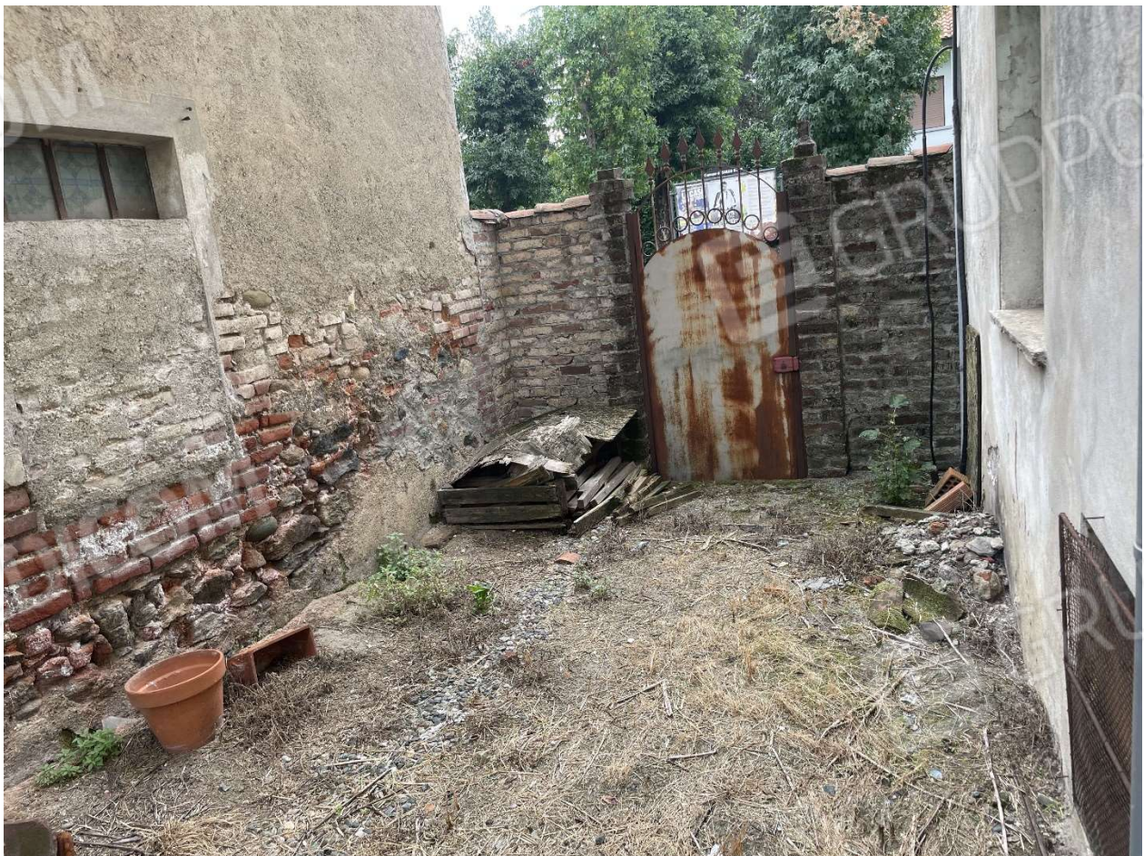
Accesso dalla strada del cortile sul retro
