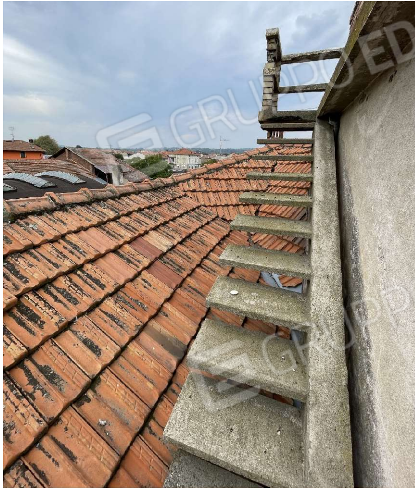
Scala di accesso al terrazzo
