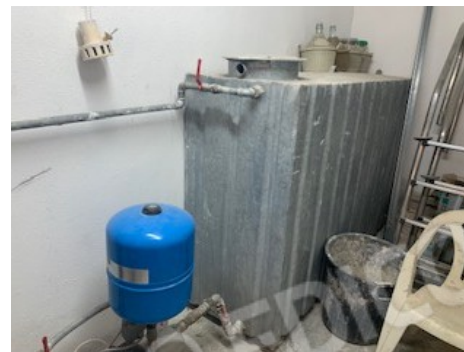
37. serbatoio acqua ed autoclave
