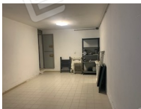
34. locale di sgombero con porta di accesso alla Centrale Termica
