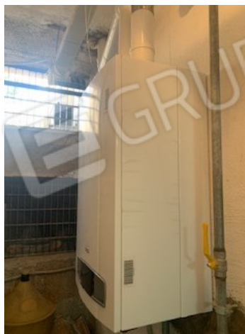
35-36. Centrale Termica e caldaia a parete
