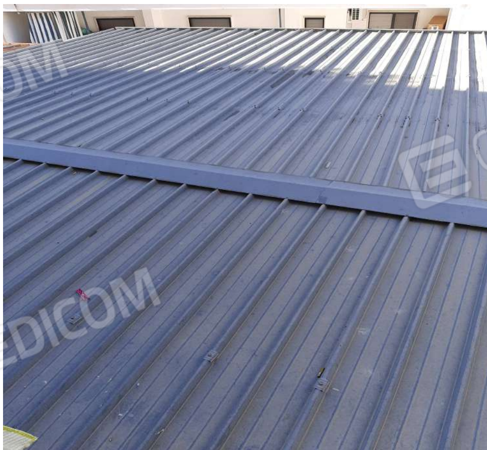
Foto n. 44 vista superiore copertura
