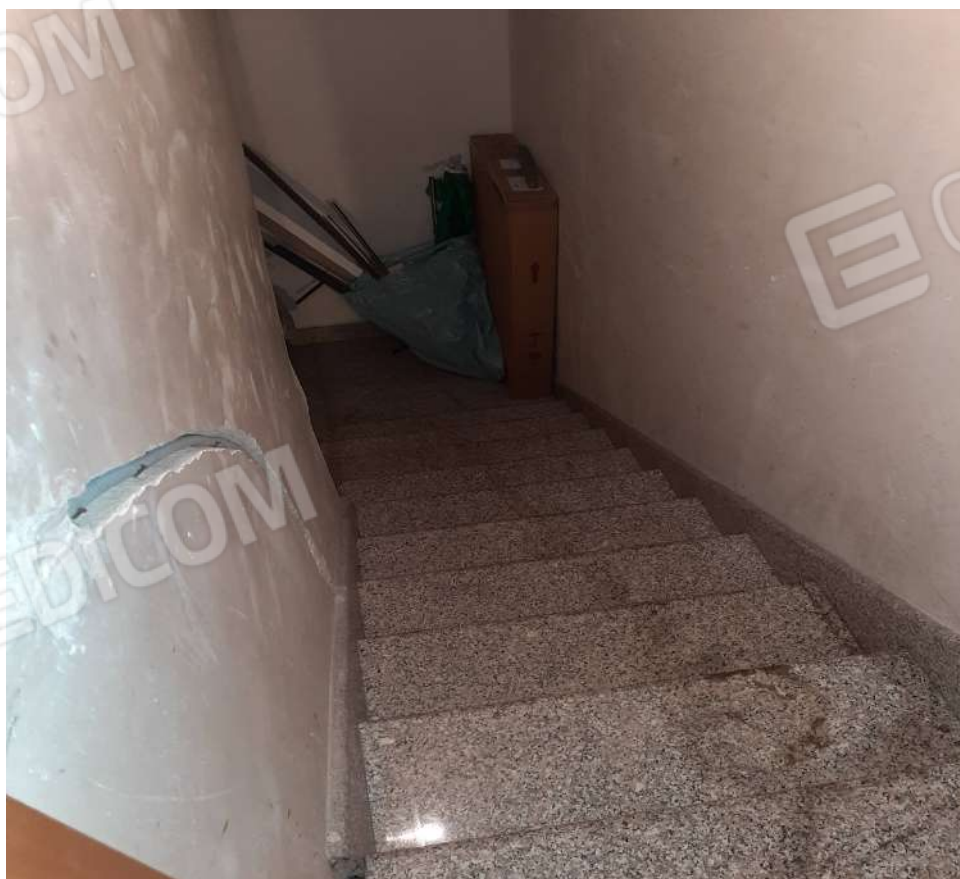
Foto n. 22 rampa accesso dall'androne al P.S.1
