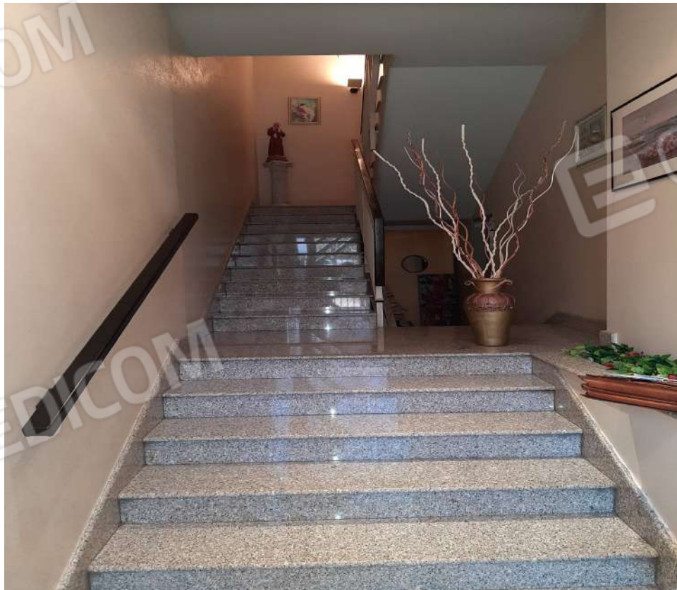
Foto n. 4 Interno androne con scala accesso P.T. e P.S.1
