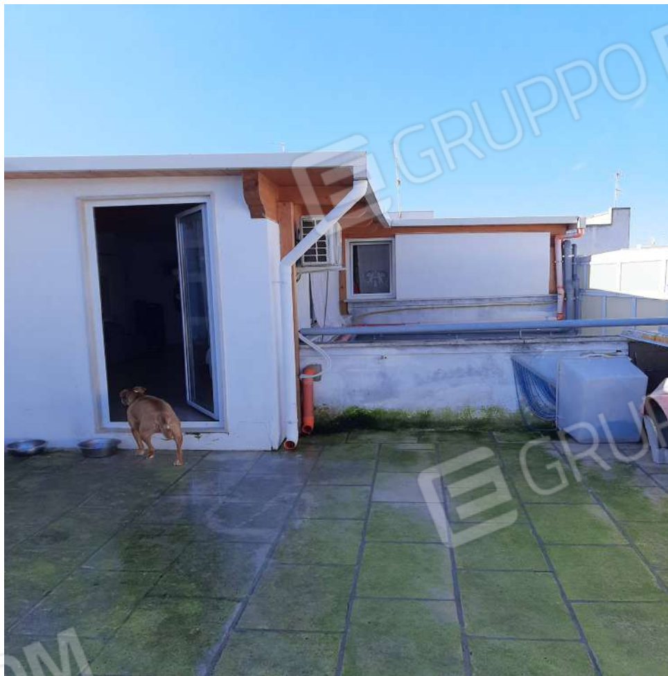
Foto n. 36 vista esterno con lastrico
