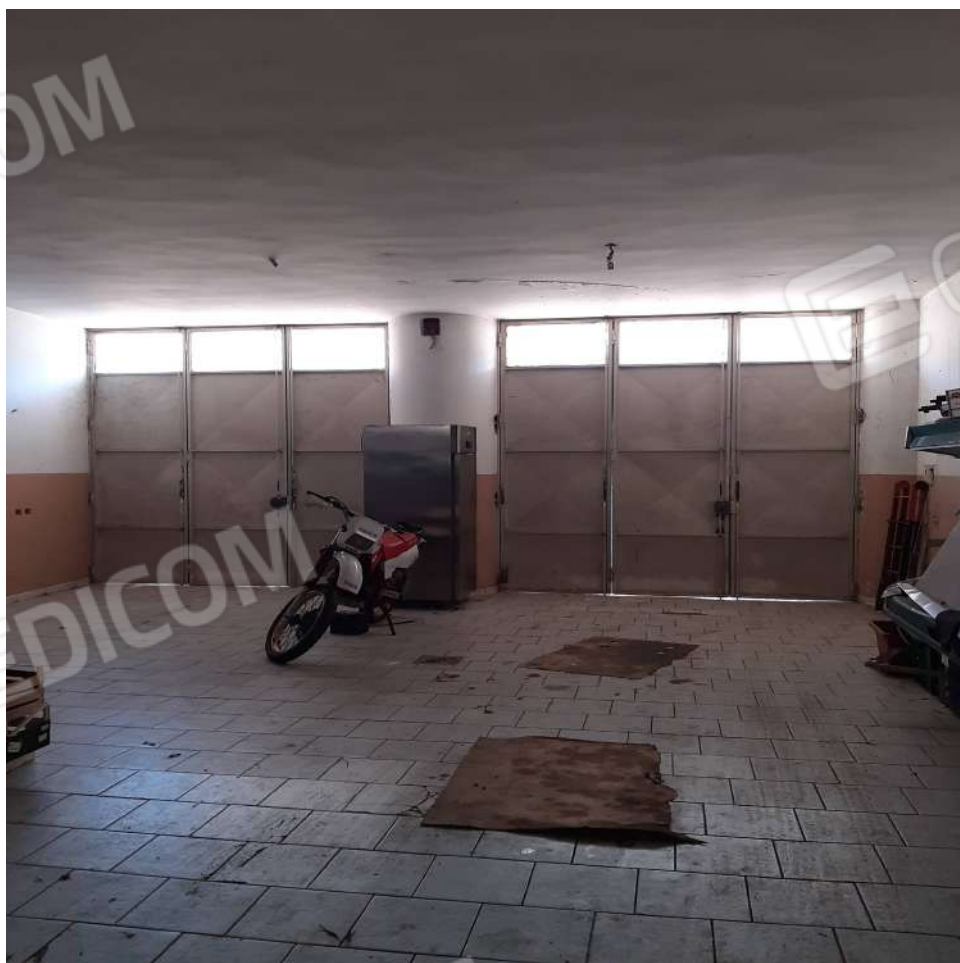
Foto n. 38 vista interna portoni accesso
