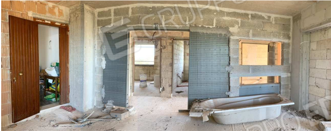
Foto n. 38. Piano Primo. Ingresso e disimpegno
