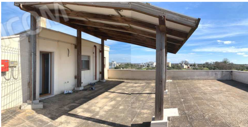
Foto nn. 59-60. Piano Secondo. Lastrico solare e tettoia con impianto fotovoltaico
