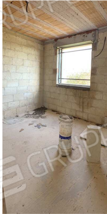
Foto nn. 44-45. Piano Primo. Disimpegno e letto 3
