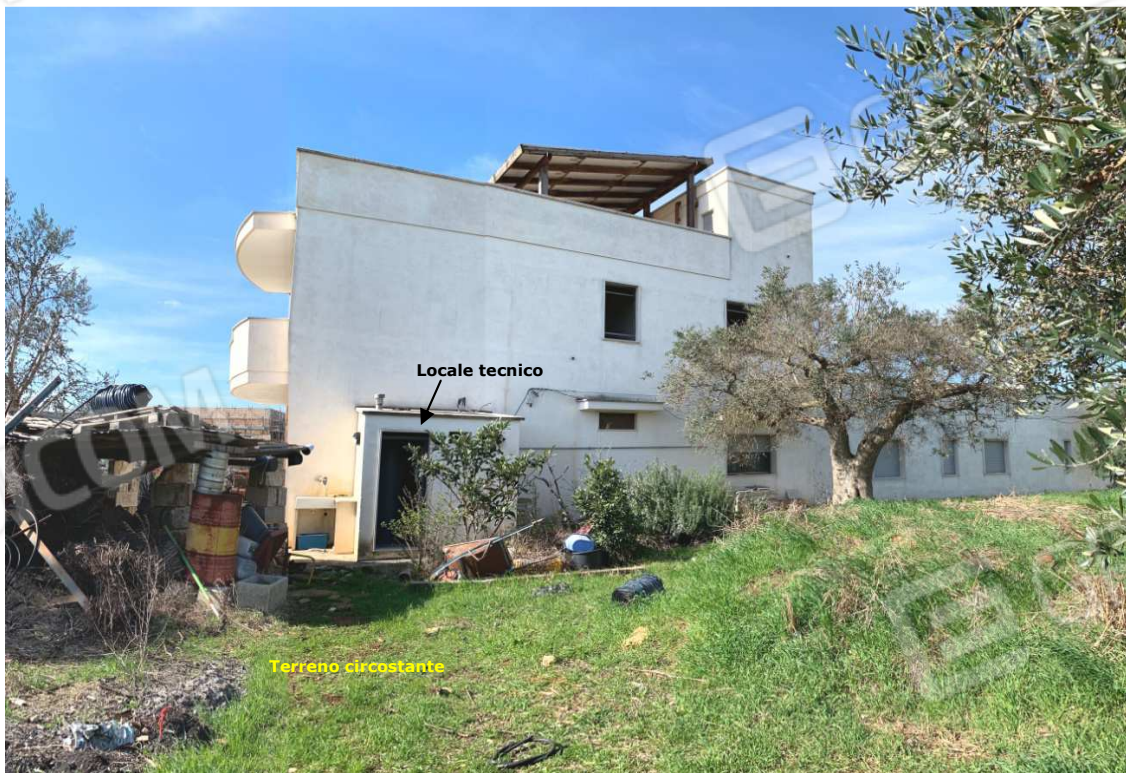
Foto n. 8. Fabbricato (lato nord)
