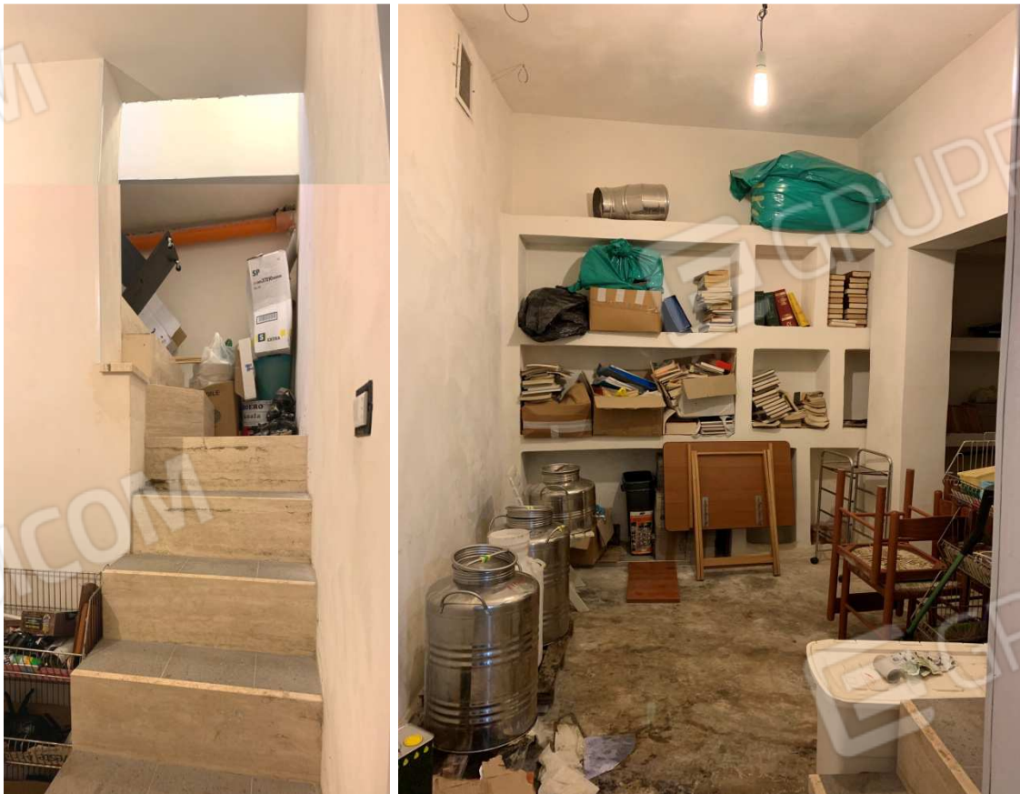
Foto nn. 64-65-66-67-68. Piano Interrato. Scala di collegamento al piano S1 e cantina 1
