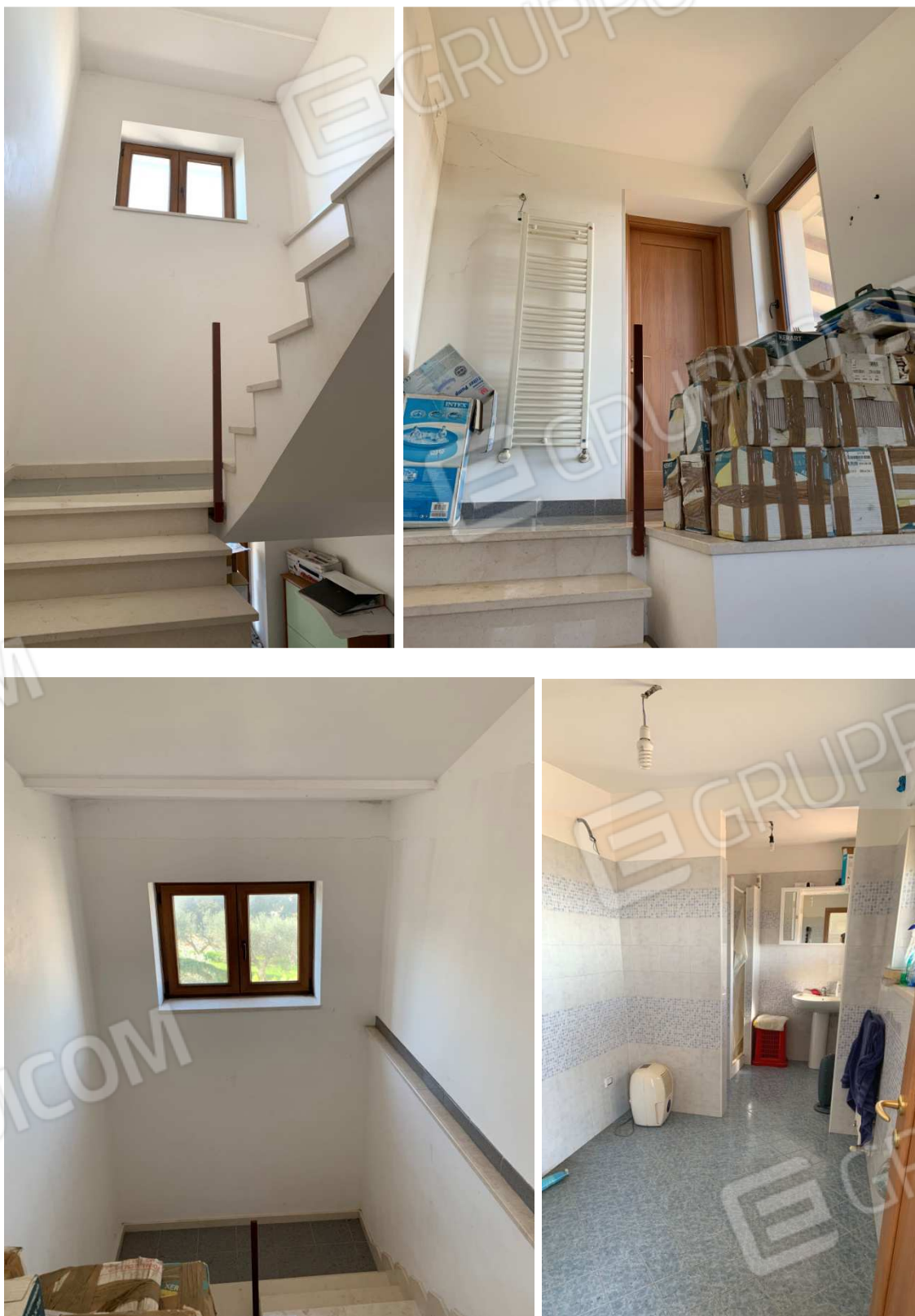
Foto nn. 52-53-54-55. Piano Secondo. Vano scala e bagno 3
