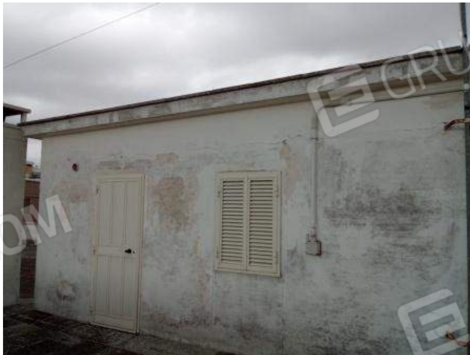
Foto n° 21 : ingresso locali Fg. 36 p.lla 2359 sub 50 e sub 49
