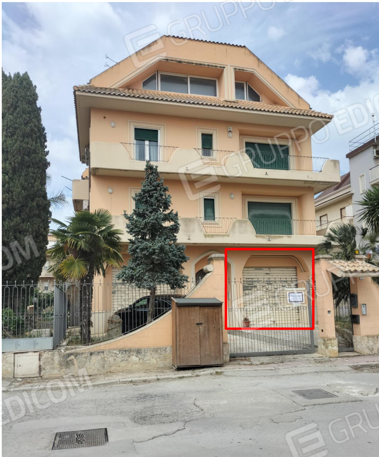
Esterno fabbricato via Guglielmo Oberdan 38
