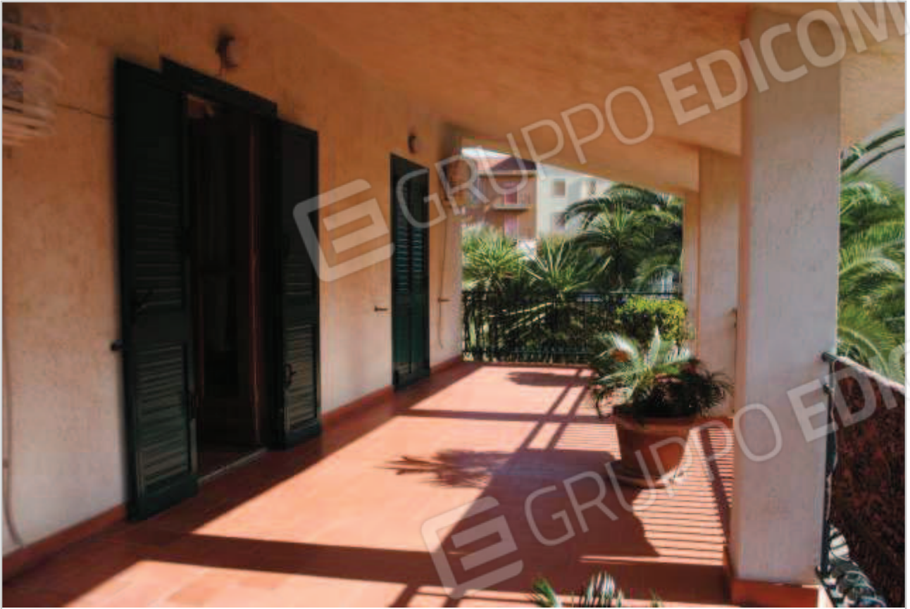
VERANDA AFFACCIO SUL LATO SUD
