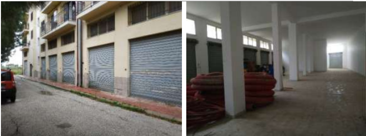
Figura 3 – A sx la vista esterna del prospetto Sud-Ovest, a dx vista interna del magazzino
