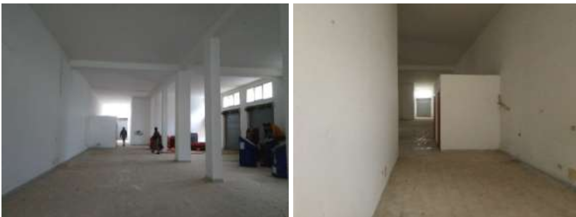
Figura 4 - Vista interna, a sx il particolare dei servizi igienici
