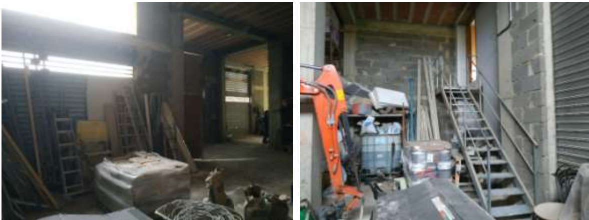
Figure 5 – A sx vista Interna del Sub 5 e particolare del vano di comunicazione col il magazzino sub 6, a dx il locale soppalcato e scala in ferro di collegamento
