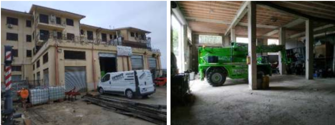
Figura 2 - Sub 6 - Vista esterna Prospetto Nord-Est, a sx vista interna del magazzino
