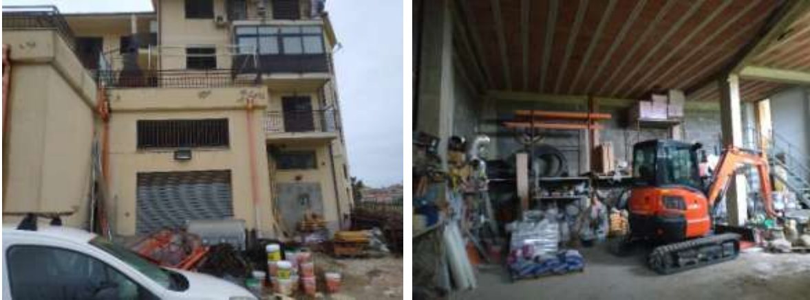
Figura 4 - Sub 5 – Vista Esterna prospetto Nord-Est, a sx vista interna del magazzino
