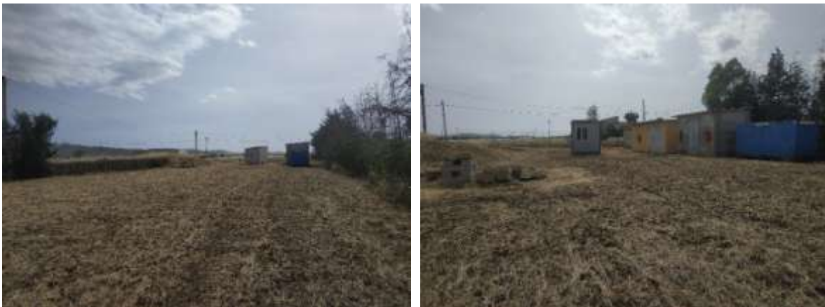
Figura 3 - Vista Terreno, particolare dei locali tecnici a servizio del complesso alberghiero
