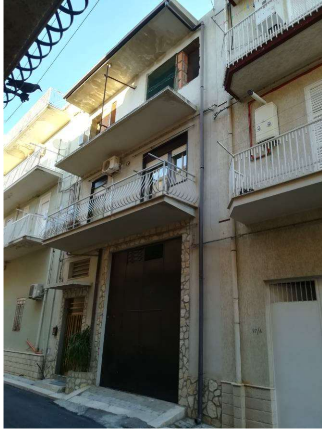
Ingresso dalla via Mascagni
