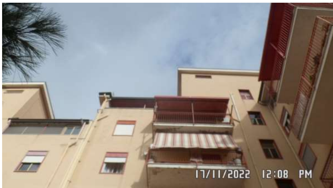
Foto 1 – Veduta sud dell'appartamento
