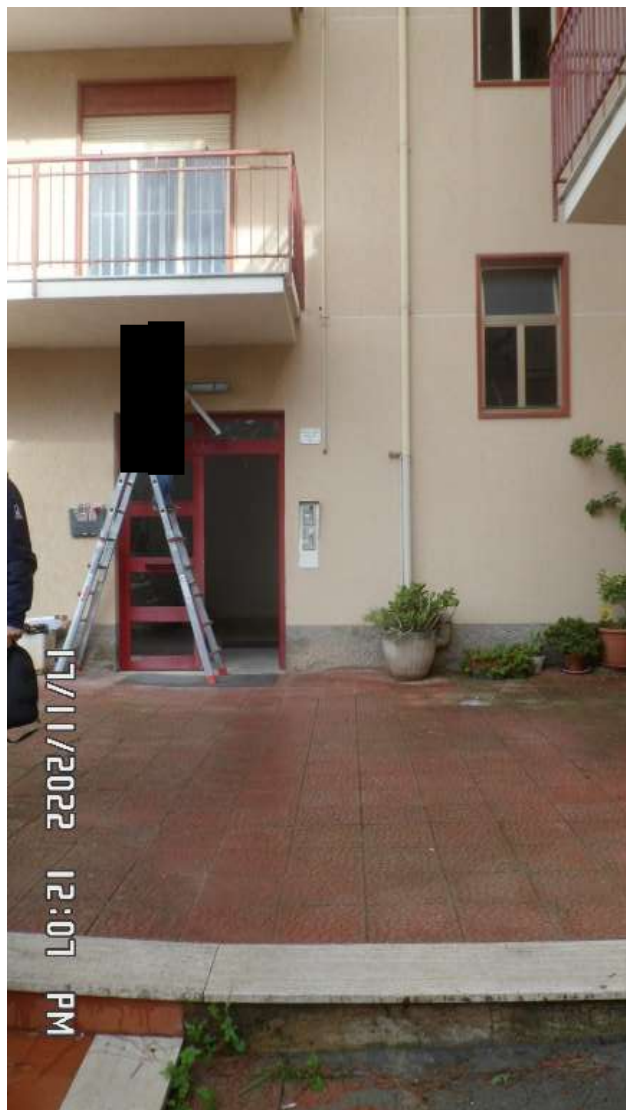
Foto 2 - Veduta del portone di ingresso del vano scala posto sul lato sud del fabbricato
