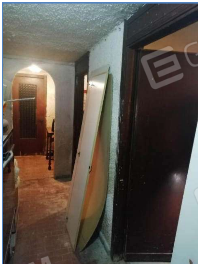
Foto 10 – Corridoio condominiale per accesso ai sub 5 e 501
