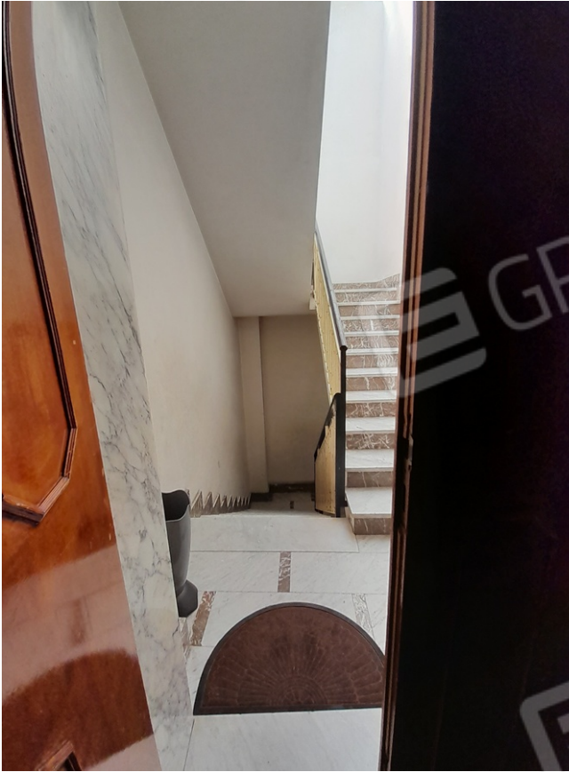
F. 8 - Scala condominiale
