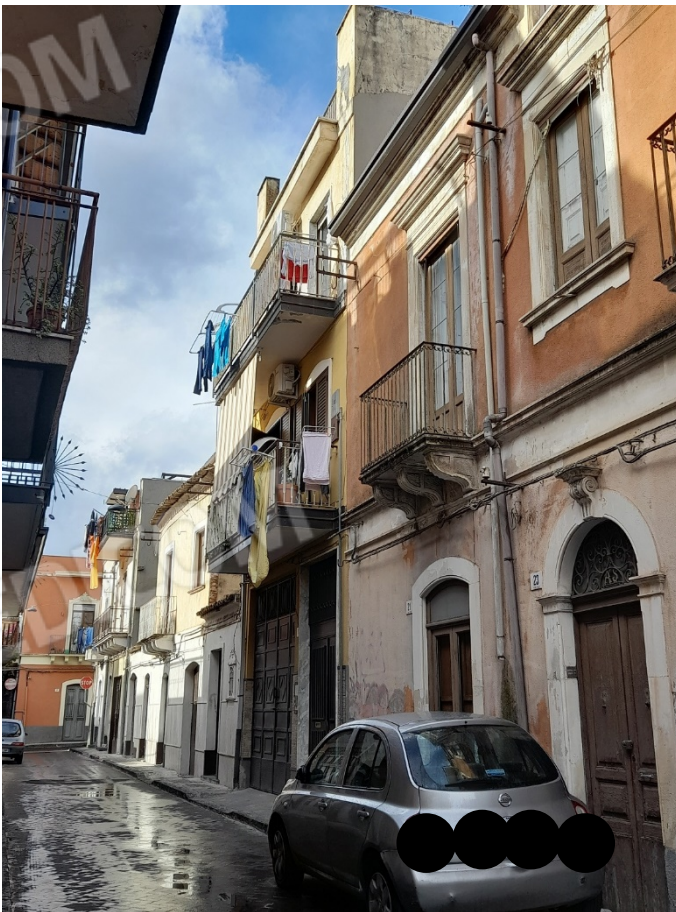
F. 3 – Immobile oggetto di perizia – Prospetto Nord, su via Filzi
