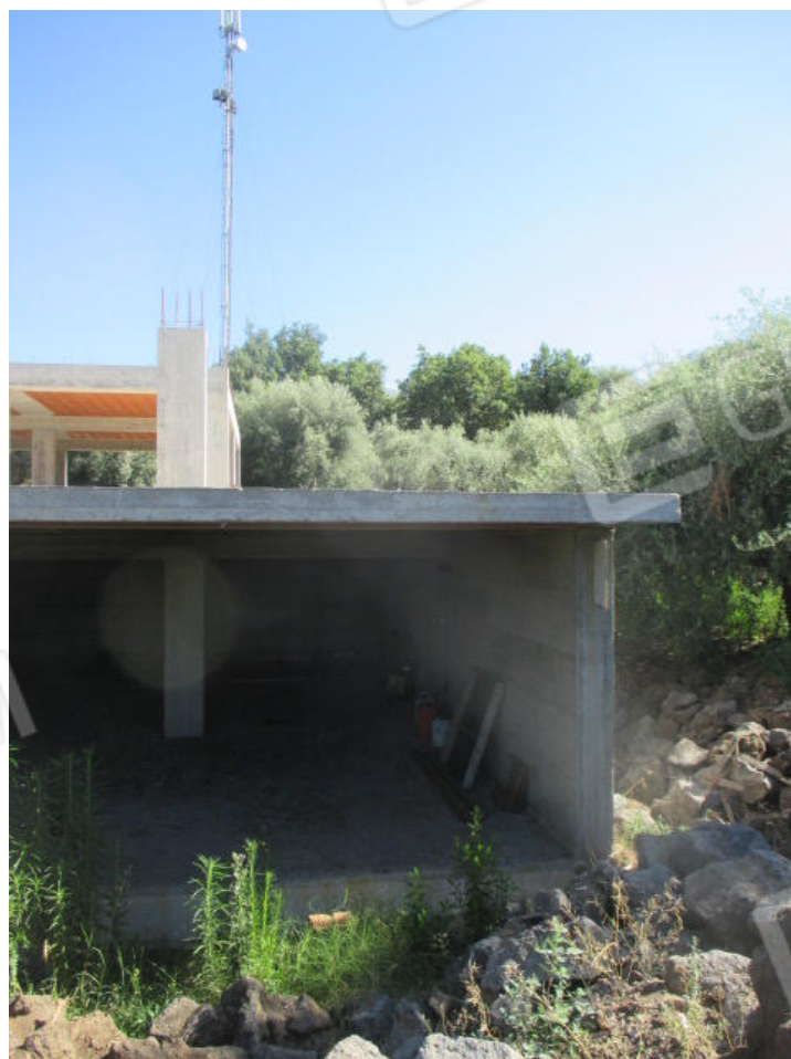
Fabbricato (Porzione da Demolire)
