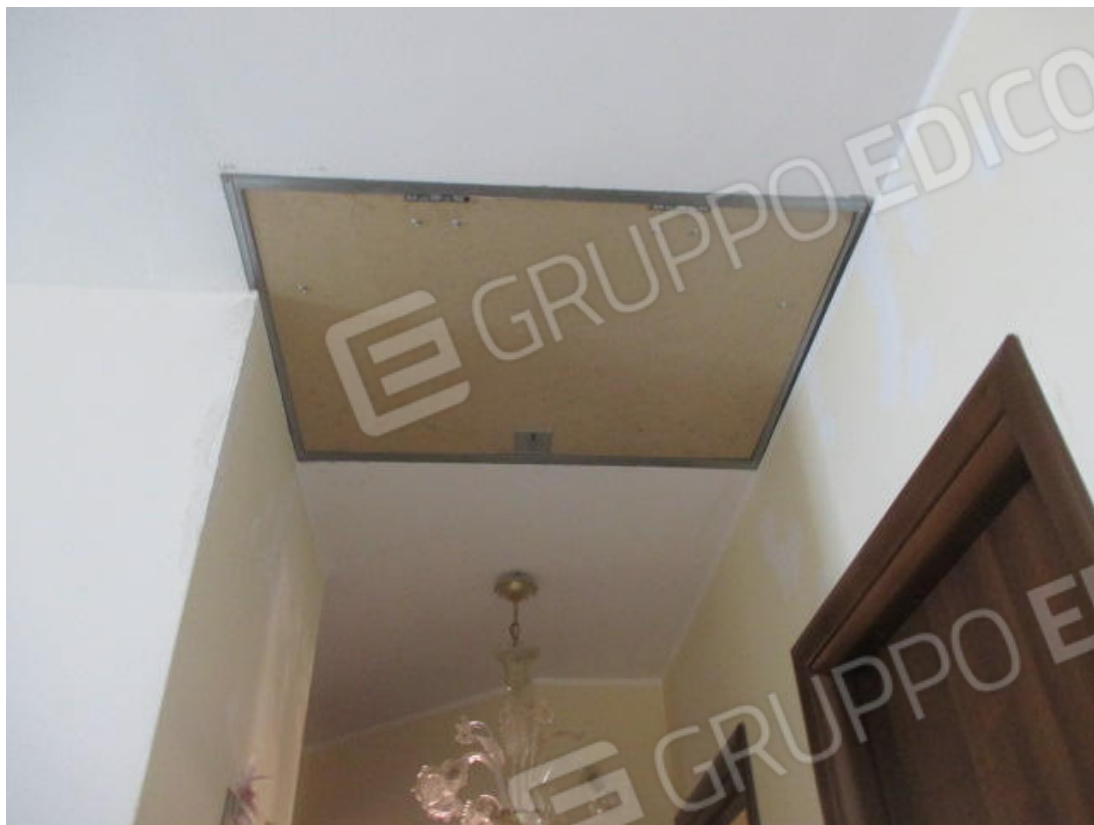
Botola di Accesso Sottotetto
