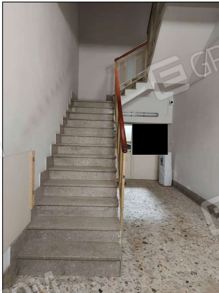
Foto corpo scala ingresso piano terra
