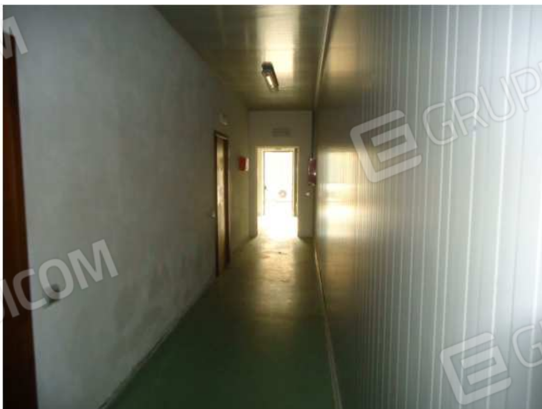
FOTO n. 18 : Interno Capannone (disimpegno servizi igienici e uffici)
