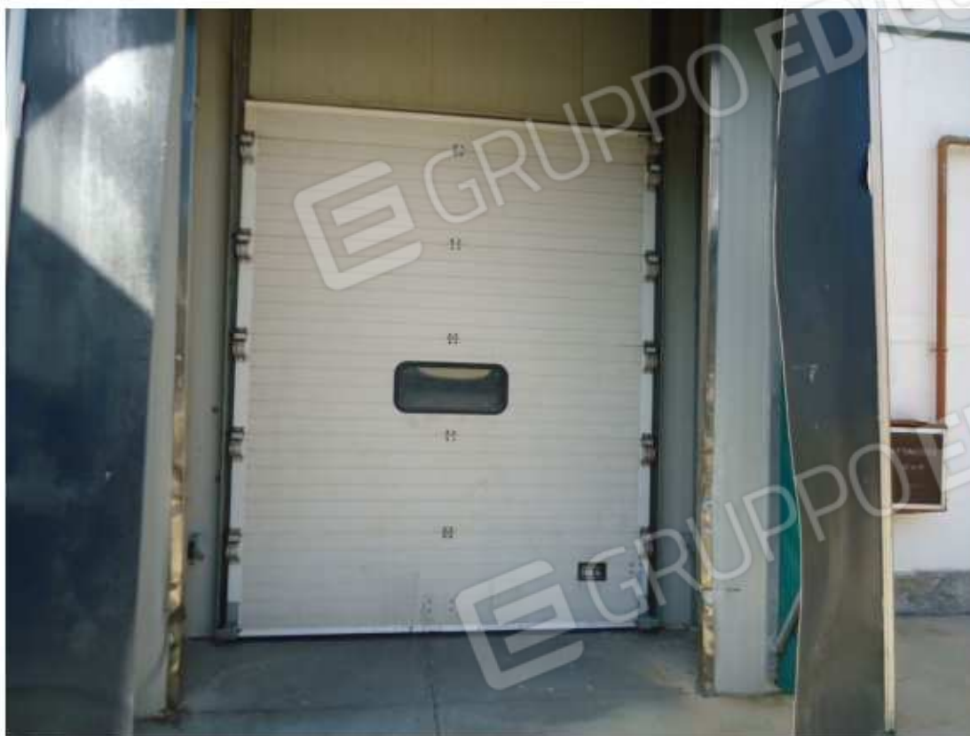
FOTO n. 7 : Porta ingresso Capannone
