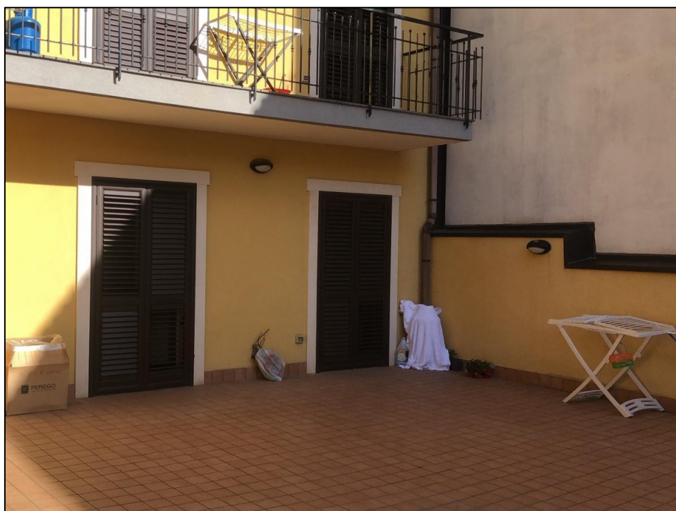
FOTO 2.6: prospetto corte esterna
