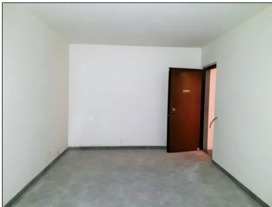
FOTO 7.1: Locale di sgombero
