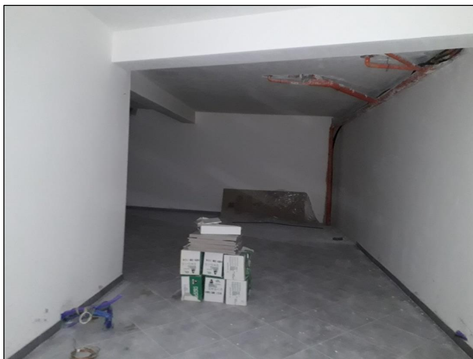
FOTO 7.2: Locale di sgombero
