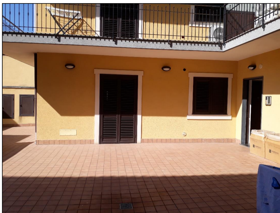
FOTO 1.6: prospetto corte esterna
