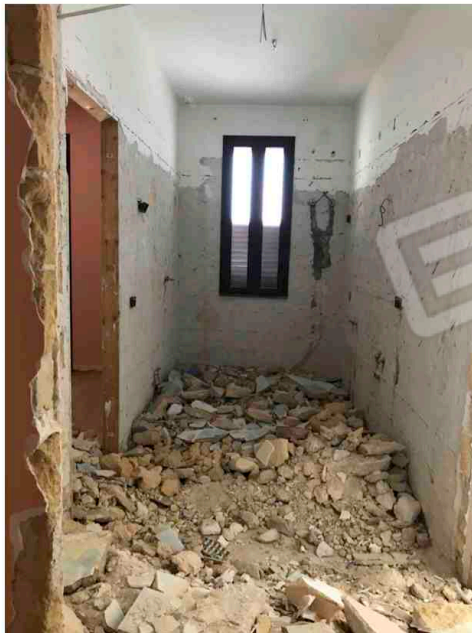
foto 8 specifica di cantiere
