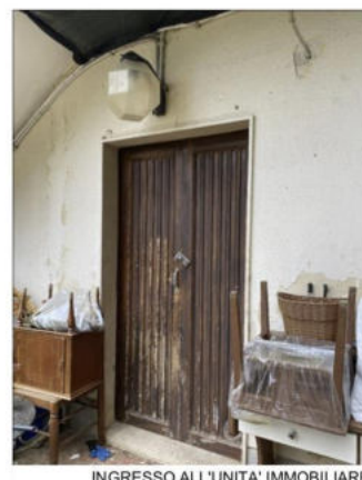
INGRESSO ALL'UNITA' IMMOBILIARE
