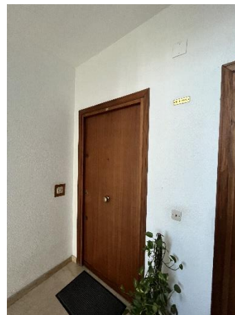
Foto 6-Pianerottolo del sesto piano
