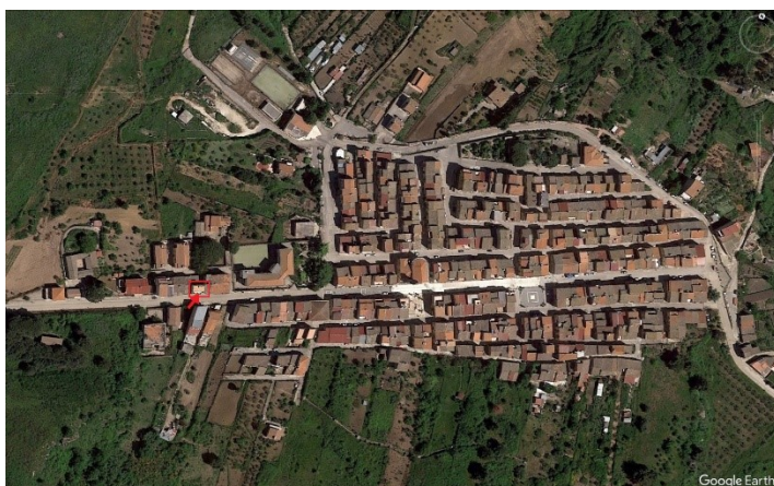
Foto 1 (Allegato 9) Foto satellitare del centro abitato di Campofelice di Fitalia (PA) con indicazione della palazzina (fonte Google Earth Pro – Google ©)
