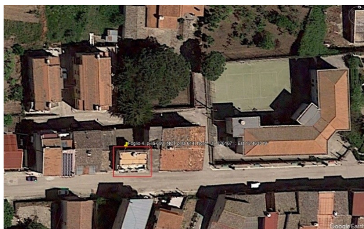
Foto 2 (Allegato 9) Foto satellitare del centro abitato di Campofelice di Fitalia (PA) con indicazione della palazzina (fonte Google Earth Pro – Google ©)
