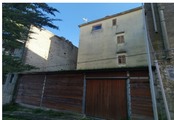
Foto 11 (Allegato 9) magazzino / autorimessa su Via S. Modesto
