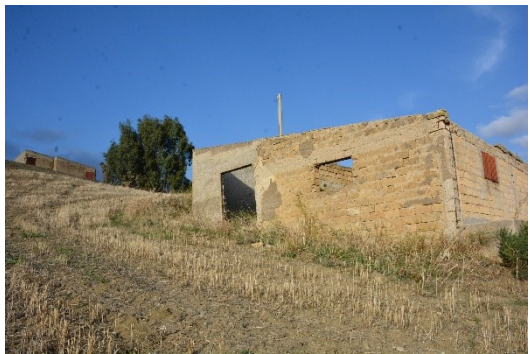
Foto 11 (Allegato 10) Magazzino non catastato che insiste sulla p.lla 408 del Fg. 13 (in fondo p.lla 744)
