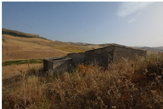
Foto 12 (Allegato 10) Magazzino non catastato p.lla 408 – foglio 13
