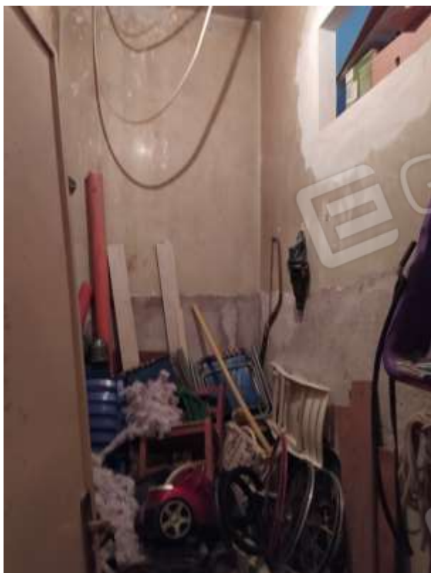
Fot. 7: vano-ripostiglio, piano primo
