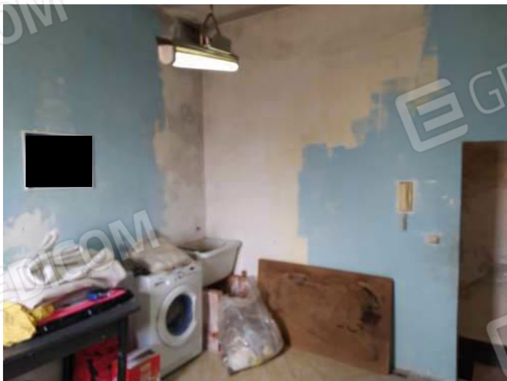
Fot. 12: vano, piano secondo
