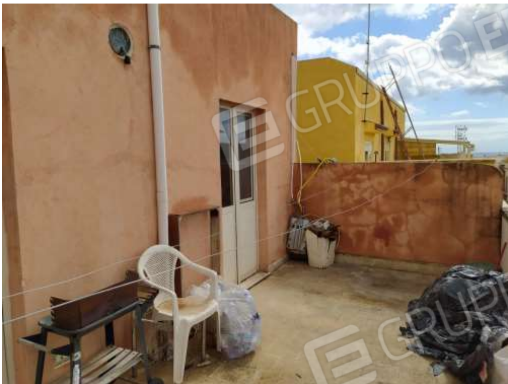
Fot. 13: terrazza esterna, piano secondo
