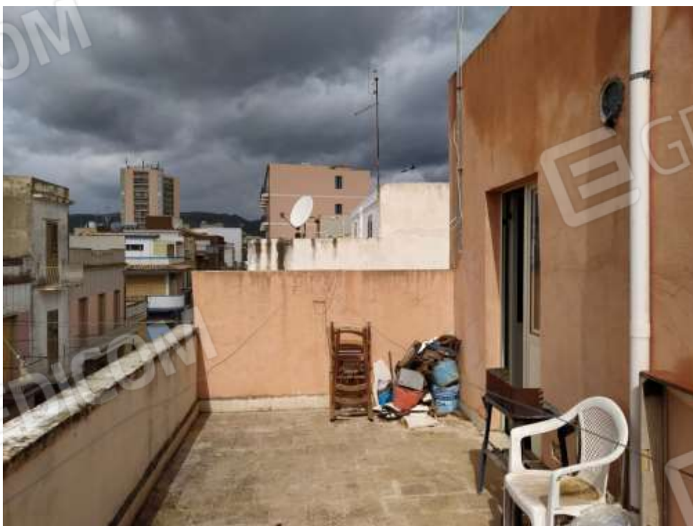
Fot. 14: terrazza esterna, piano secondo
