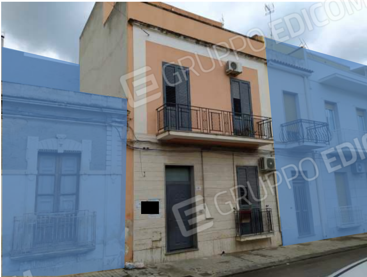
Fot. 17: prospetto su Via G. Mameli, particolare
