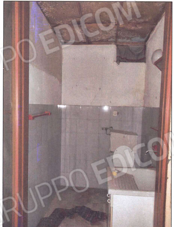
Foto 14-15 - Foto della camera 2 da cui si accede al wc 2, quest'ultimo ricavato abusivamente all'interno del cavedio. Occorre ripristinare la superficie del cavedio e l'apertura finestrata.
