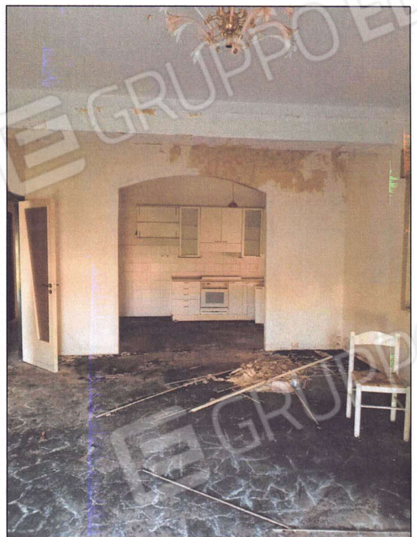
Foto 16 - 17 - Vista del soggiorno dal lato cucina e dal lato finestrato. L'ambiente ha pavimentazione in marmo, è rifinito con intonaco che in alcune parti è mancante e presenta macchie e umido.
