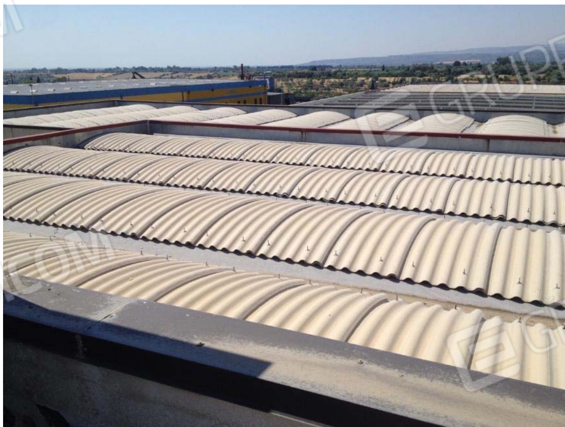
Foto 17 – copertura corpo B
