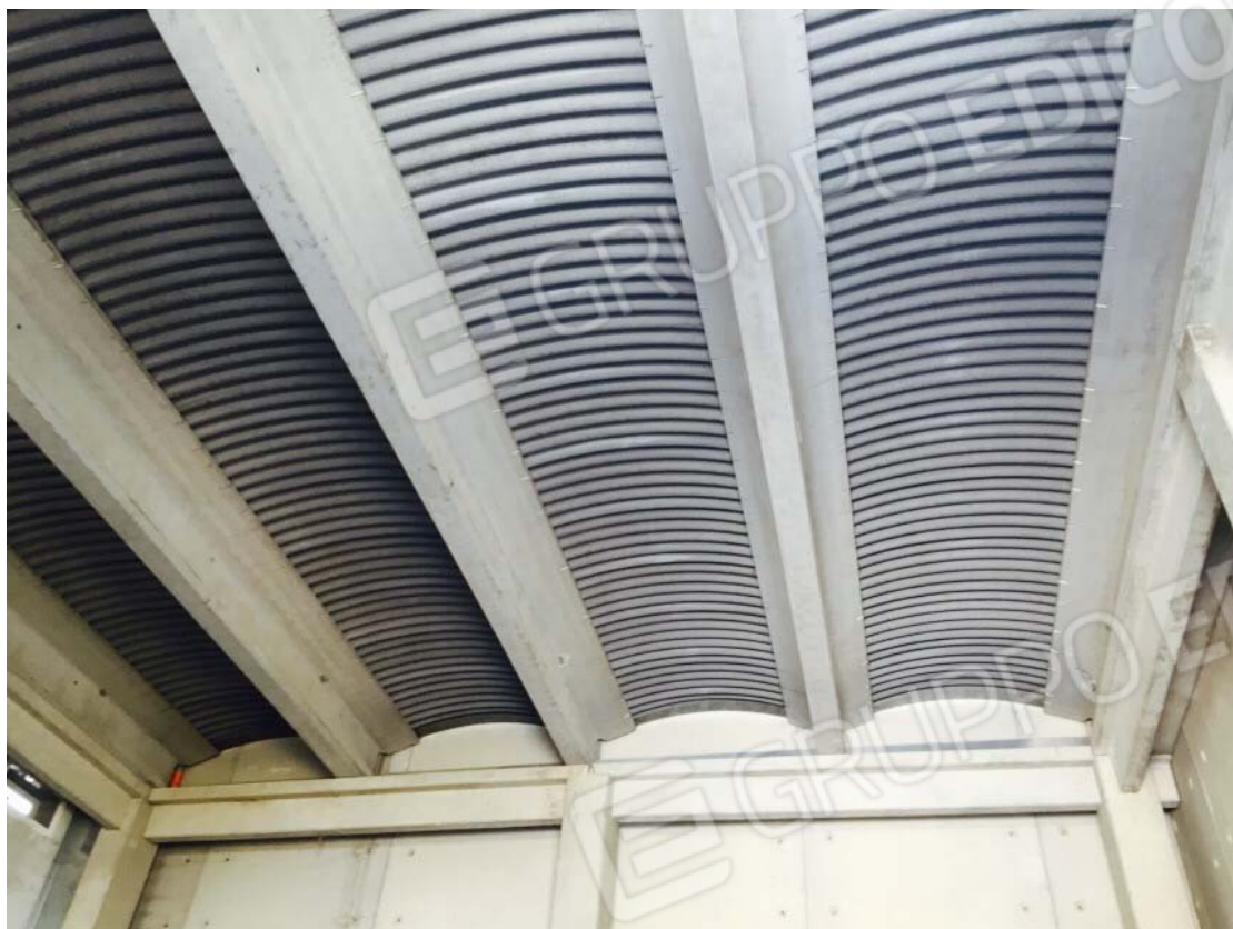
Foto 9 – intradesso copertura laboratorio artigianale
