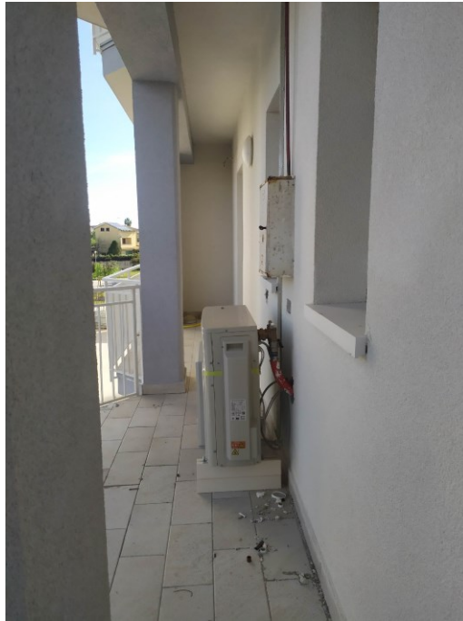
Balcone sul prospetto nord-est
