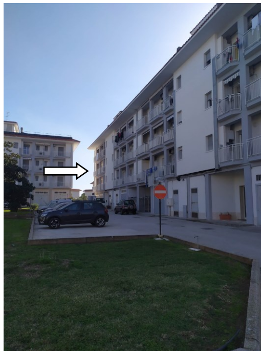
Spazio condominiale con indicazione del prospetto nord-est della scala in cui sono l'appartamento e il garage pignorati
