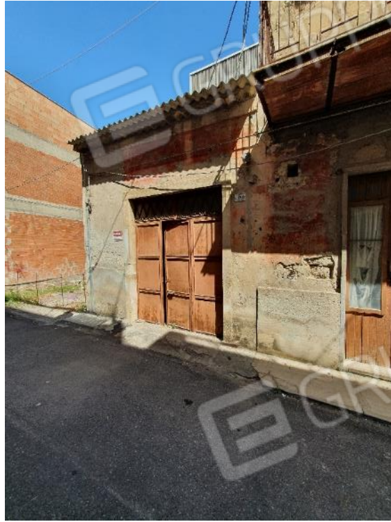
Foto n. 25 – Garage via San Michele
