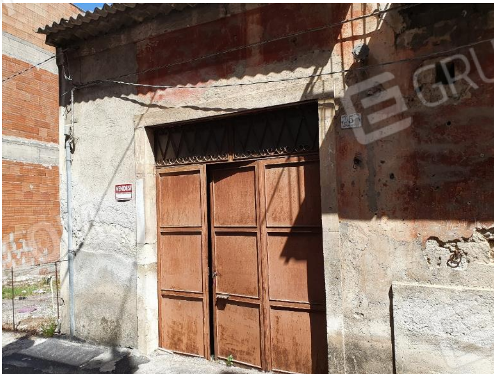
Foto n. 26 – Garage via San Michele
