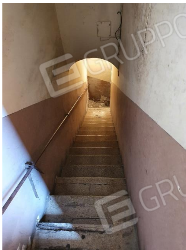
Foto n. 5 – Scala a P.T. di via Magenta
