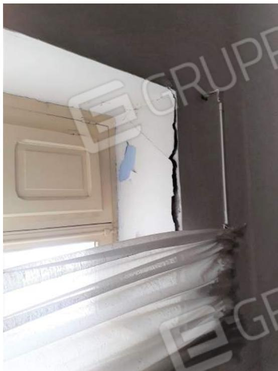
**Foto 12** - Particolare del distacco intonaco.
