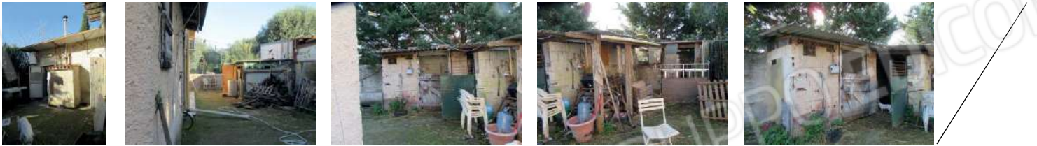
Foto da 63 a 83_vista interna del lotto: fabbricati e area di pertinenza ad est e a sud
