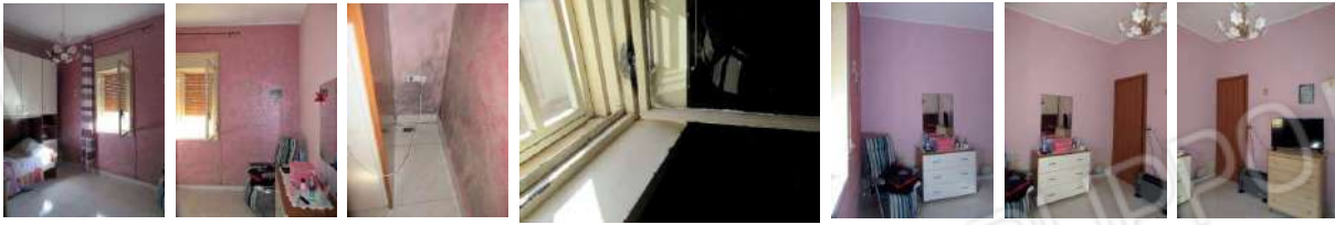
Foto da 139 a 150_ vano A6
