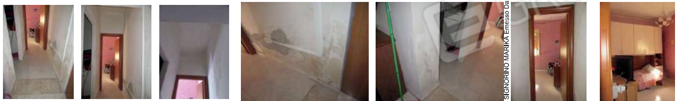
Foto da 132 a 136_ vano A7
