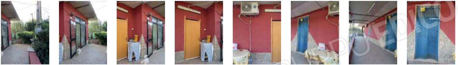
Foto da 89 a 96_immobile A_prospetto ad ovest
