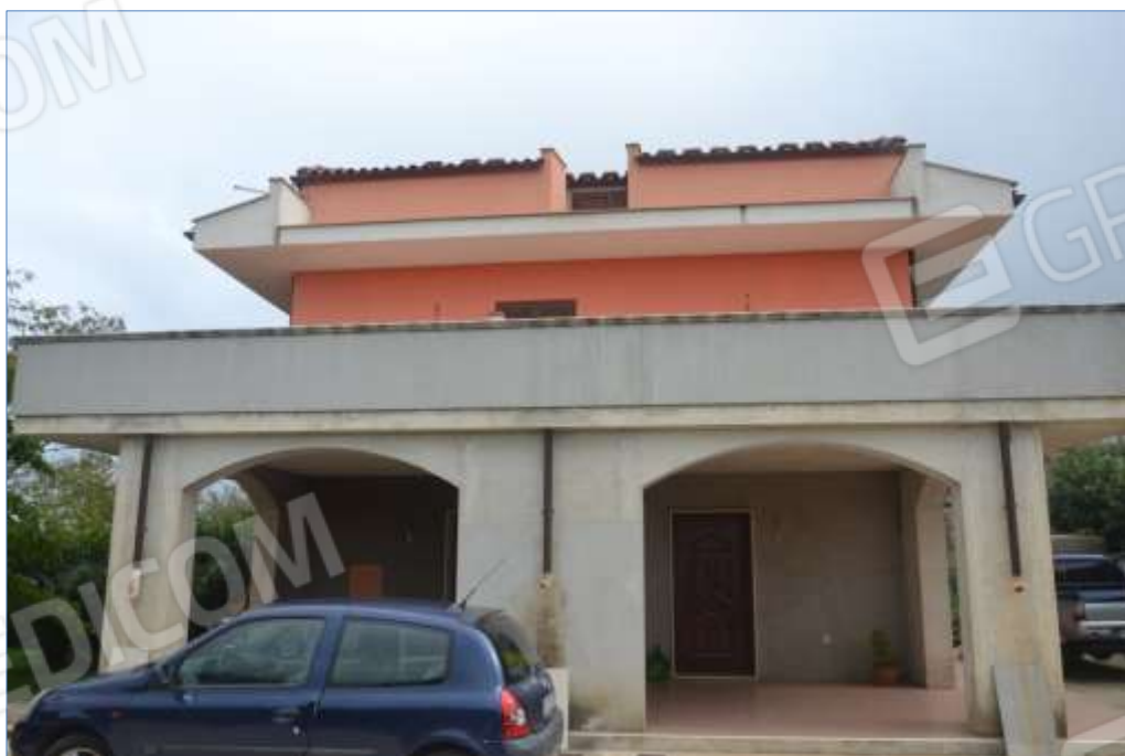
Fot. 2 Piano terra, prospetto ovest: veranda-portico da cui si accede all'unità immobiliare, vista da ovest
