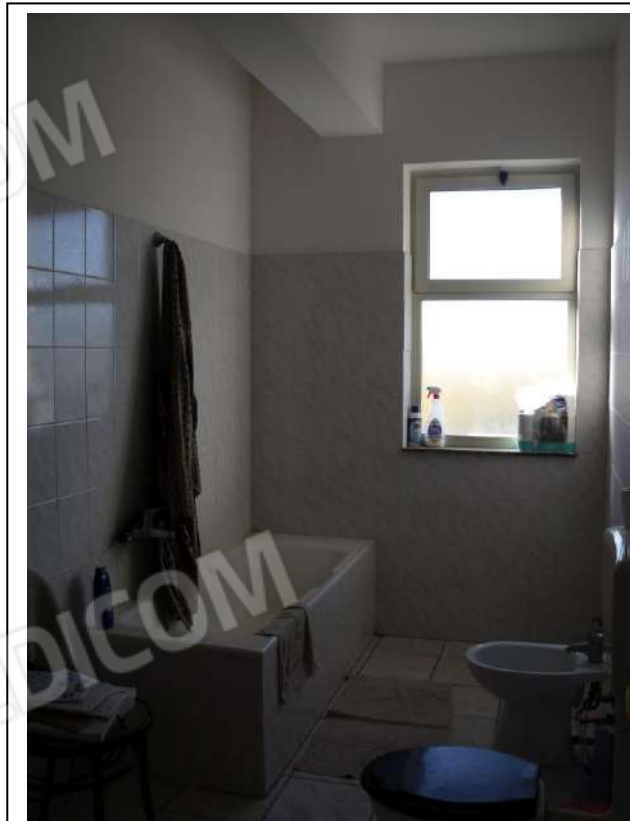
77. Interno “servizio igienico” dell’unità immobiliare al piano primo, con vista lato ovest, in foto buono stato di manutenzione.
