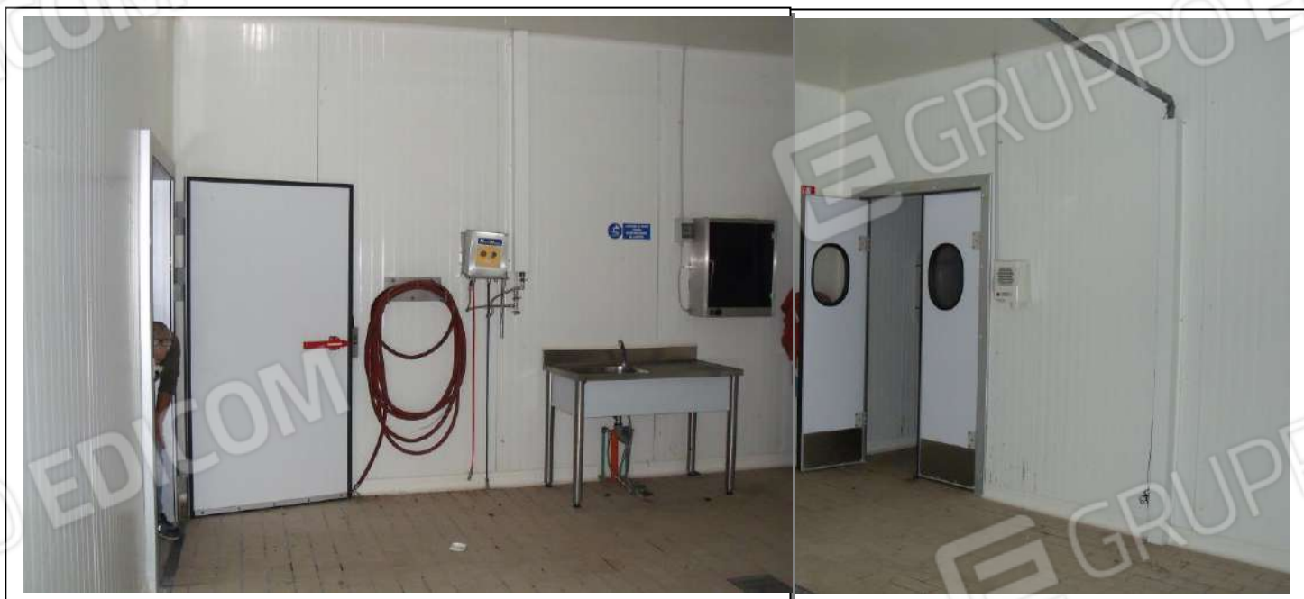
15. Interno “sala selezione” dell’unità immobiliare al piano terra, con vista lato sud-est, in foto sufficiente stato di manutenzione.
