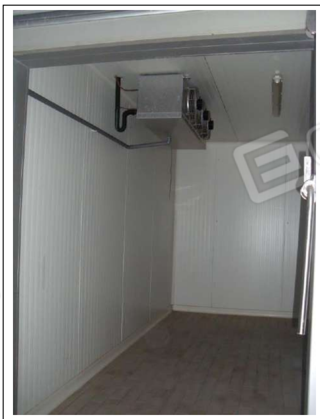
34. Interno “cella frigorifera” dell’unità immobiliare al piano terra, con vista lato nord-est, in foto sufficiente stato di manutenzione.
