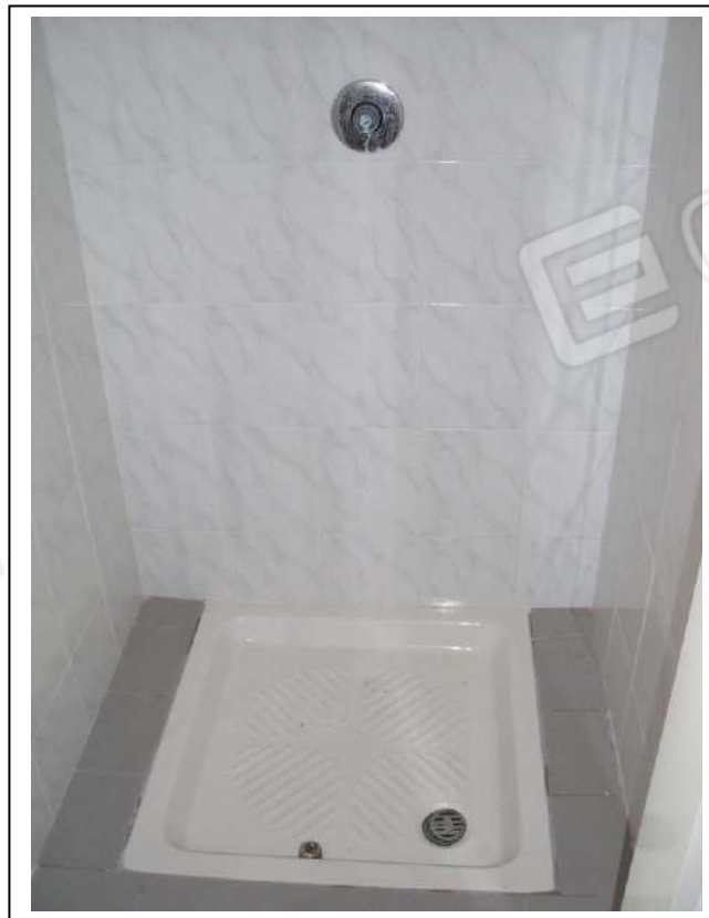
52. Interno “docce spogliatoio uomini” dell’unità immobiliare al piano primo, con vista lato nord-ovest, in foto buono stato di manutenzione.
