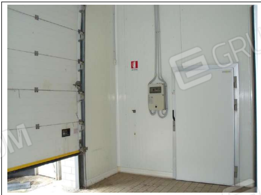
29. Interno "ingresso merci" dell'unità immobiliare al piano terra con vista lato ovest, in foto sufficiente stato di manutenzione.
