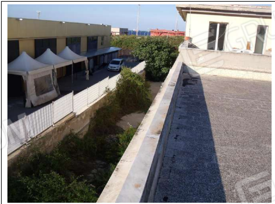
92. Esterno “terrazza praticabile” dell’unità immobiliare al piano primo, con vista lato nord, verso area di pertinenza laterale al fabbricato.
