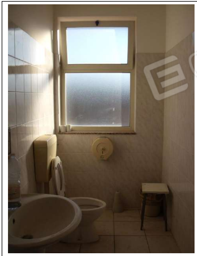
70. Interno “servizio igienico” dell’u. i. al piano primo, con vista lato sud-ovest, in foto sufficiente stato di manutenzione.
