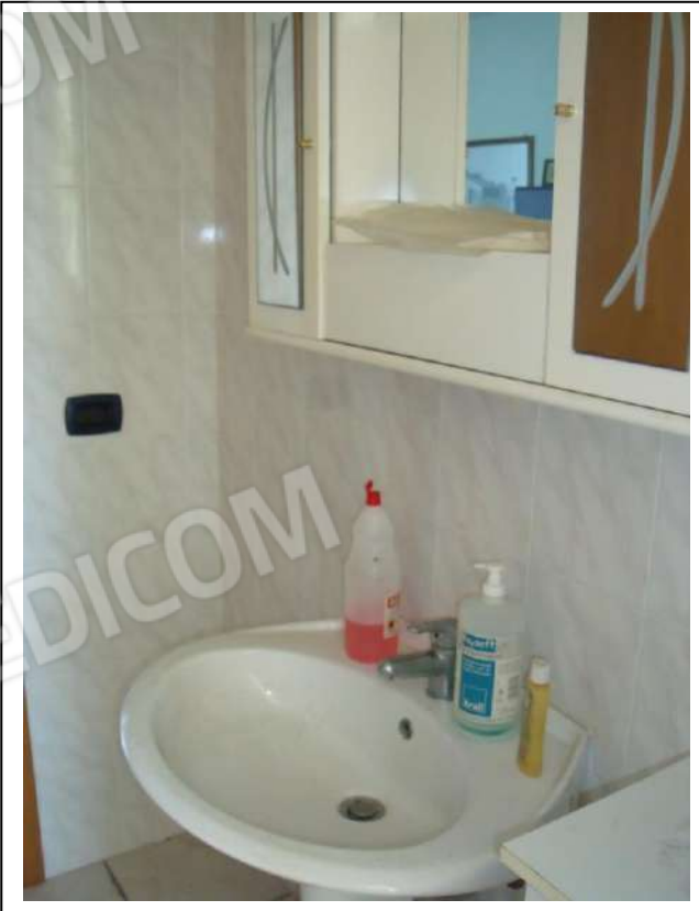
67. Interno “antibagno servizio igienico dell’uff. direzione” dell’u. i. al piano primo, con vista lato est, in foto sufficiente stato di manutenzione.
