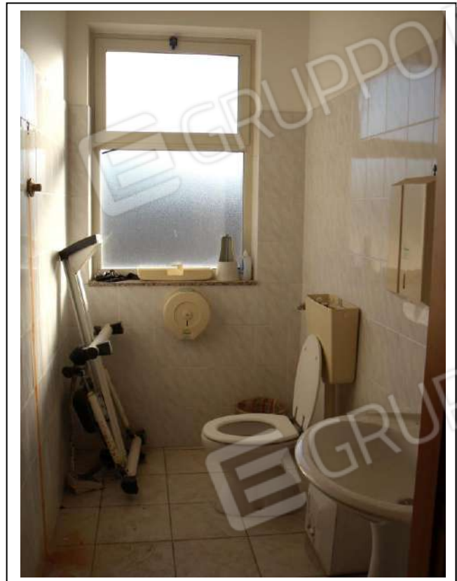
68. Interno “servizio igienico” dell’u. i. al piano primo, con vista lato sud-ovest, in foto sufficiente stato di manutenzione.
