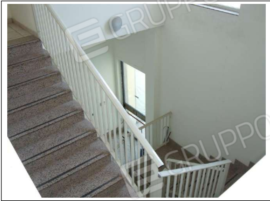
41. Interno dell'unità immobiliare (uffici industria) al piano primo con vista lato est, in foto corpo scala di collegamento con il piano inferiore (industria). Buono lo stato di manutenzione.
