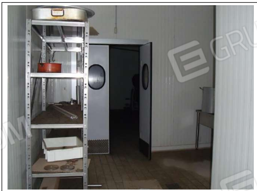
23. Interno “laboratorio” dell’unità immobiliare al piano terra, con vista lato sud-est, in foto insufficiente stato di manutenzione.
