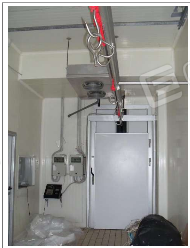
11. Interno "ingresso merci" dell'unità immobiliare al piano terra con vista lato nord-ovest, in foto sufficiente stato di manutenzione.
