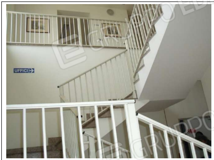
10. Interno dell'unità immobiliare (industria) al piano terra con vista lato sud-ovest, in foto corpo scala di collegamento con il piano superiore (uffici amministrativi dell'industria). Buono lo stato di manutenzione.
