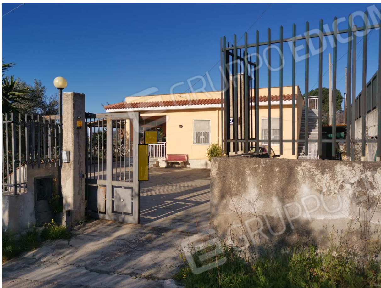
Figura 5: Vista del cancello di ingresso all'immobile
