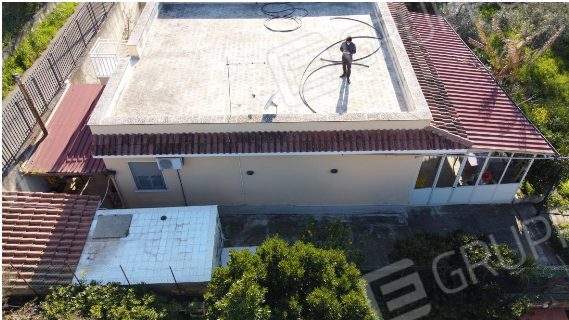
Figura 30: Vista del terrazzo di copertura
