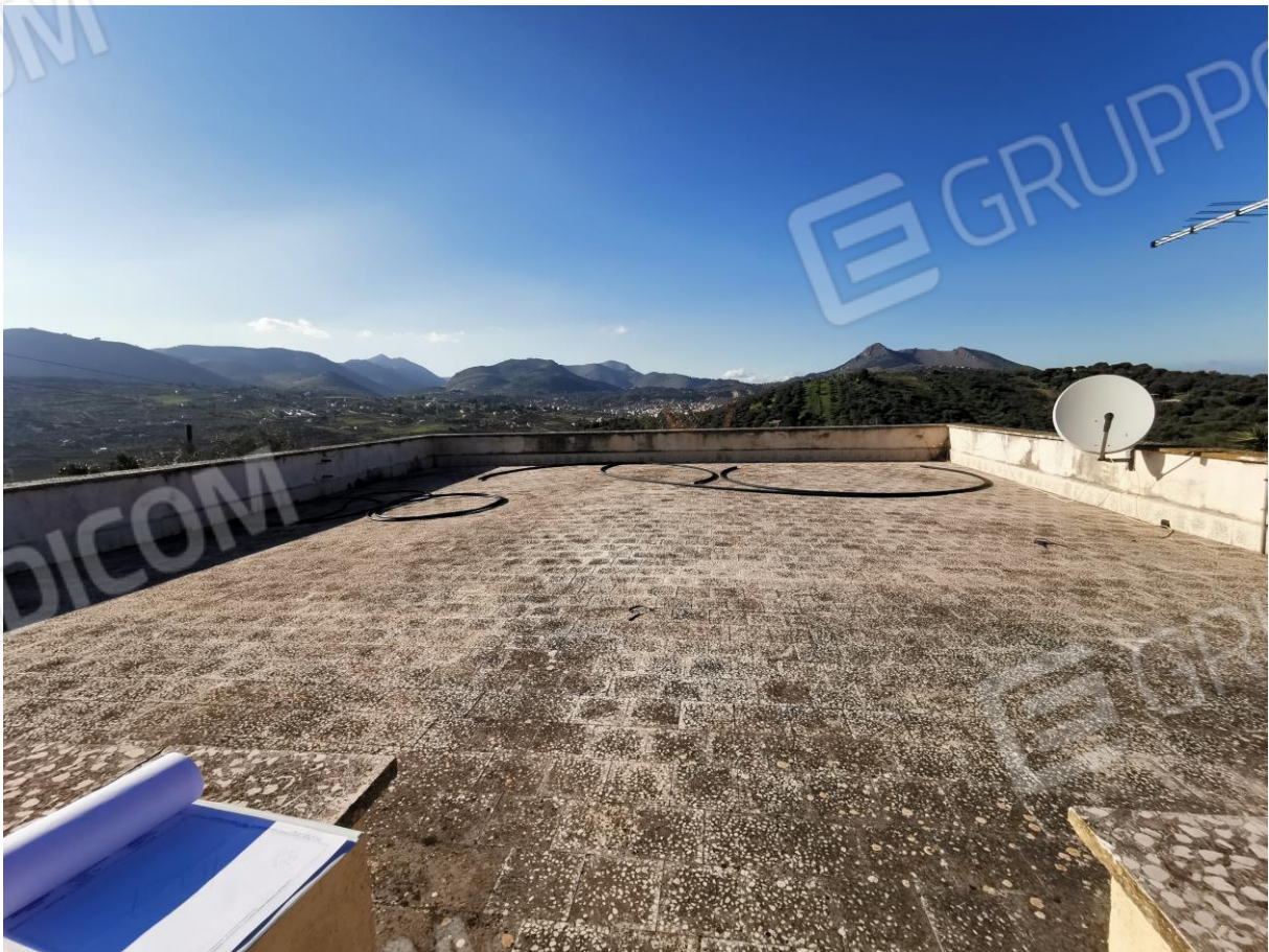
Figura 28: Vista del terrazzo di copertura
