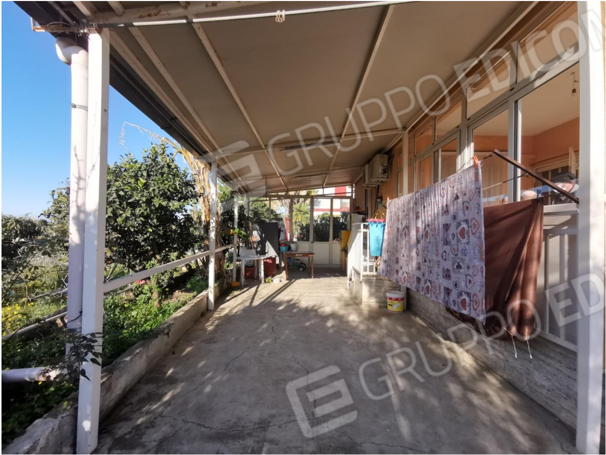
Figura 25 Vista della tettoia 1
