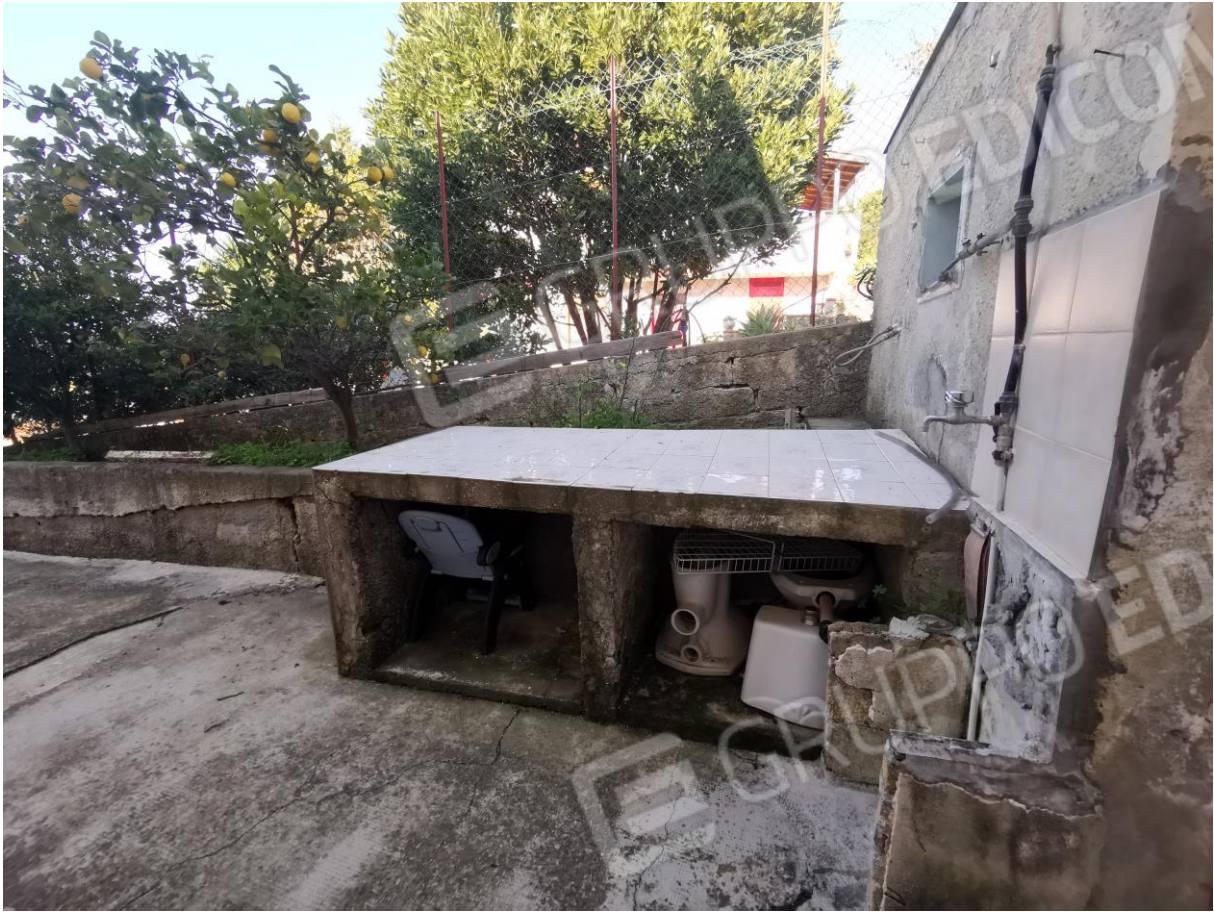
Figura 23: Vista del piano esterno in muratura
