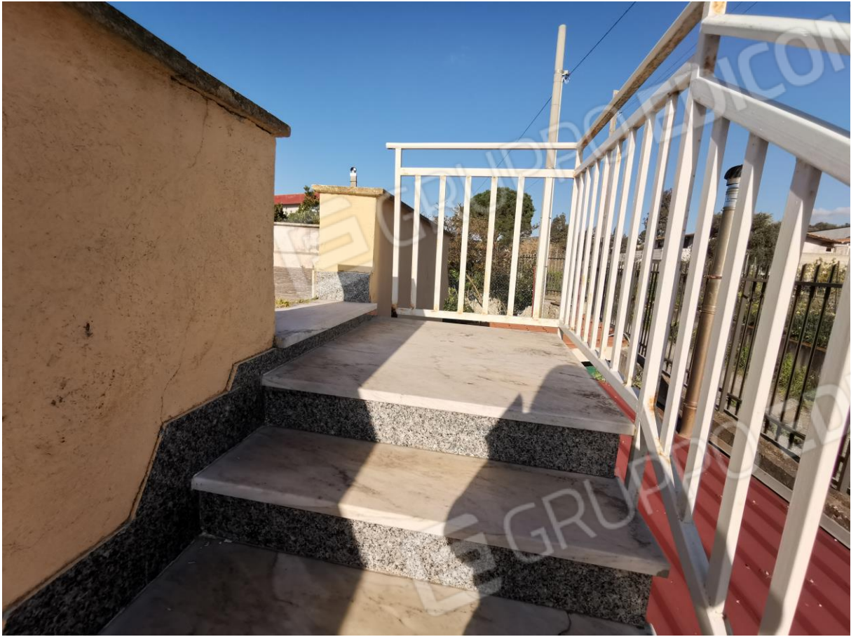
Figura 27: Vista della scala di accesso al terrazzo di copertura
