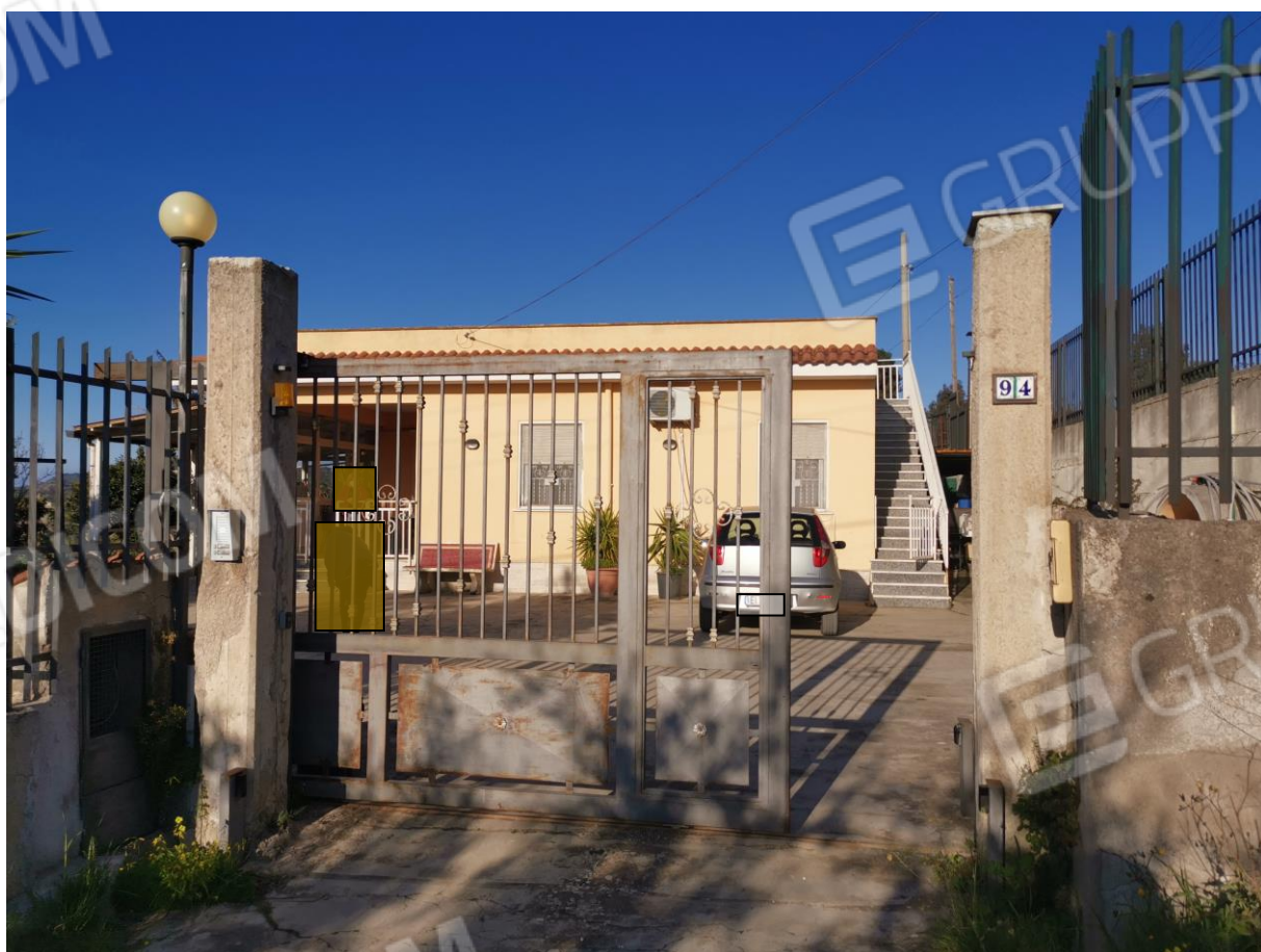
Figura 6: Vista del cancello di ingresso all'immobile
