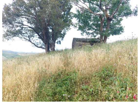
Foto 14 – Manufatto su p.lla 173
