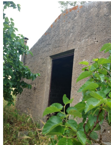
Foto 22 - Manufatto su p.Illa 175
