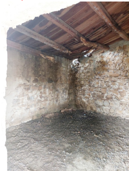
Foto 20 – Manufatto su p.lla 173
