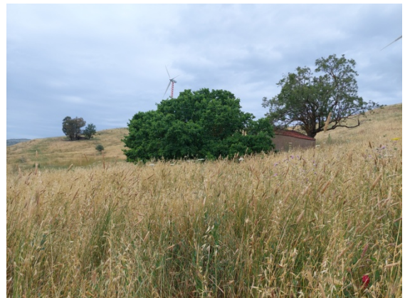
Foto 16 – Manufatto su p.lla 175
