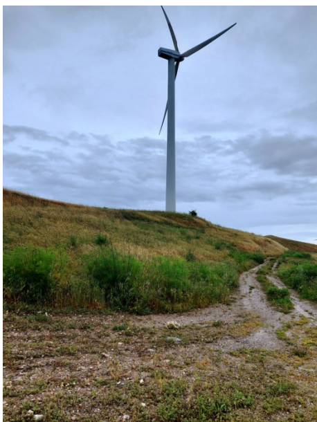
Foto 9 - Pala eolica su p.lla 175
