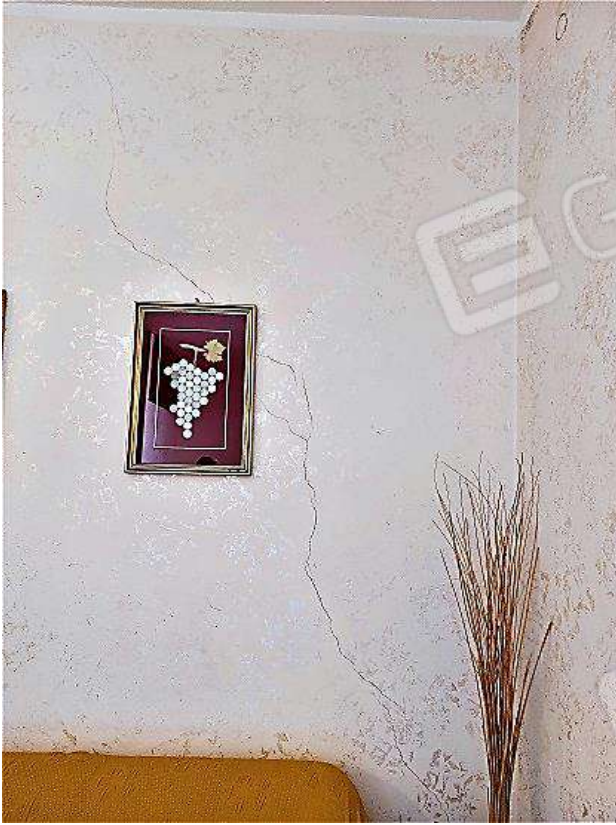
53 e 54 = Abitazione di 2°P – vano M (part. lesione e muffa)
