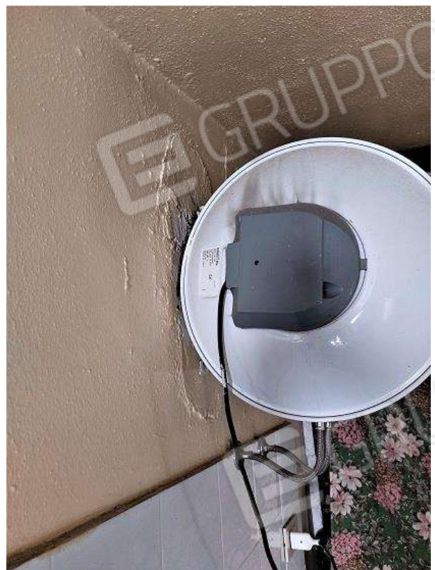
85 ed 86 = Abitazione di 3°P – vano R – W.C. (part. dell'infisso e delle infiltrazioni)
