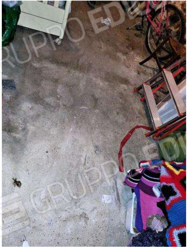
25 = Magazzino di P.T. – vano C (part. del pavimento)
