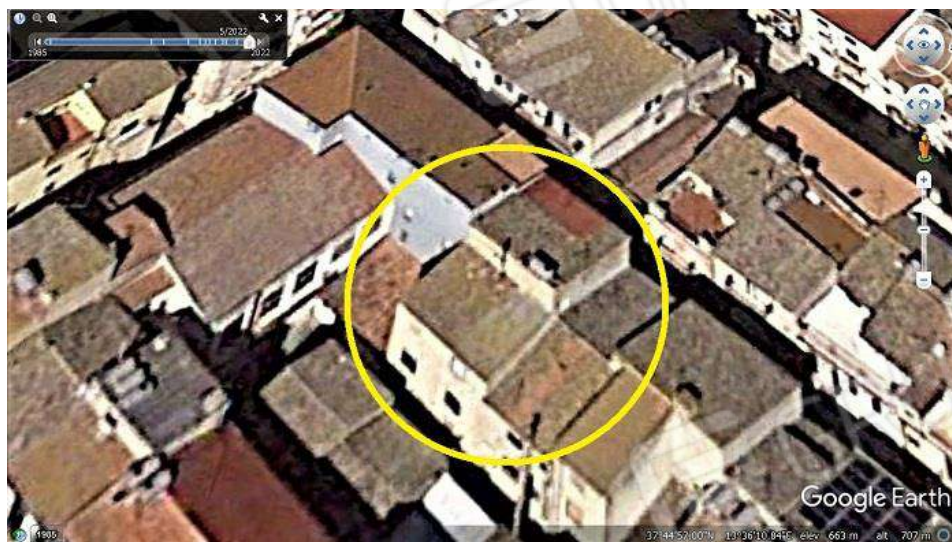
Immagine satellitare maggio 2022 (vista da Sud-Est lato Via Lucania)
