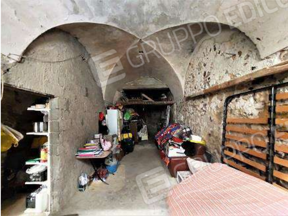
17 = Magazzino di P.T. – vano E (vista verso vani A e D)
