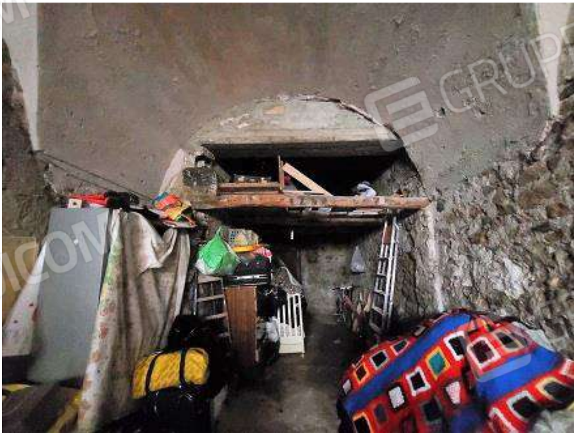
18 = Magazzino di P.T. – vano E (vista verso vano D)
