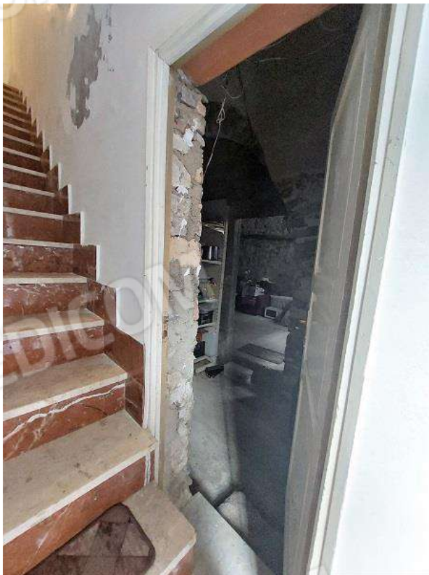
4 = Ingresso al magazzino di P.T.
