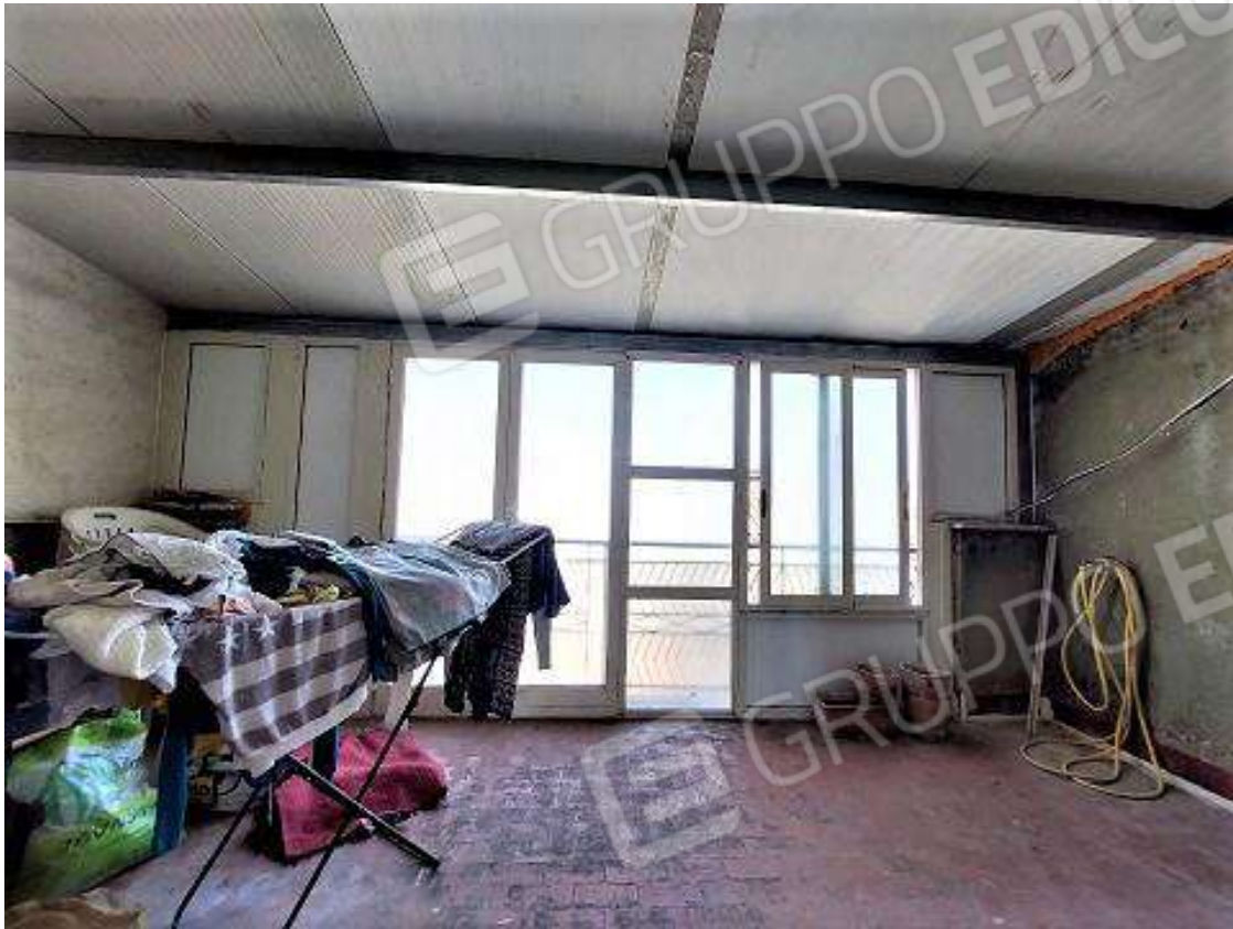
89 = Abitazione di 3°P – vano S (terrazza con veranda abusiva)
