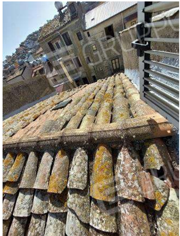
74 = Abitazione di 3°P – vista dalla finestra della scala
