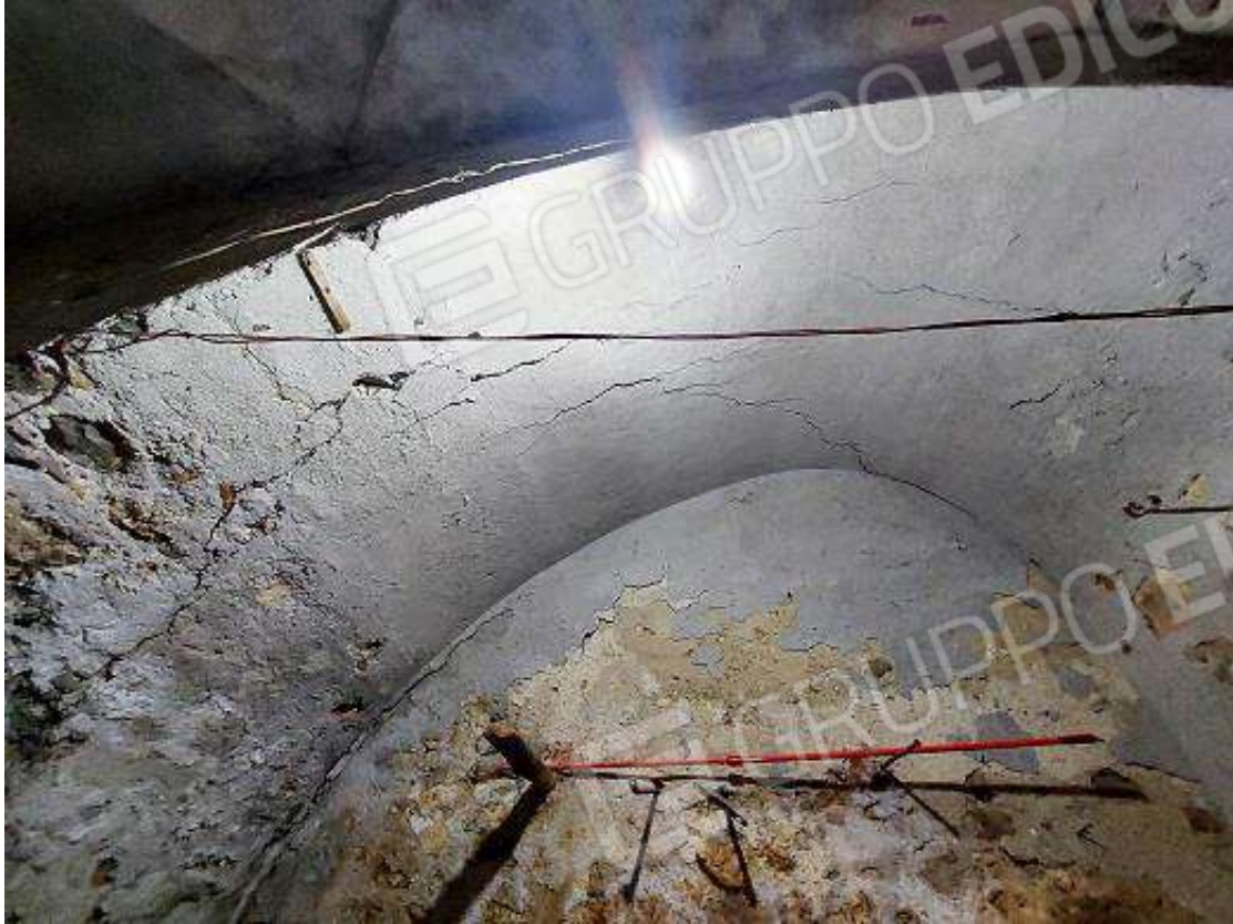
10 = Magazzino di P.T. – particolare della struttura vano B
