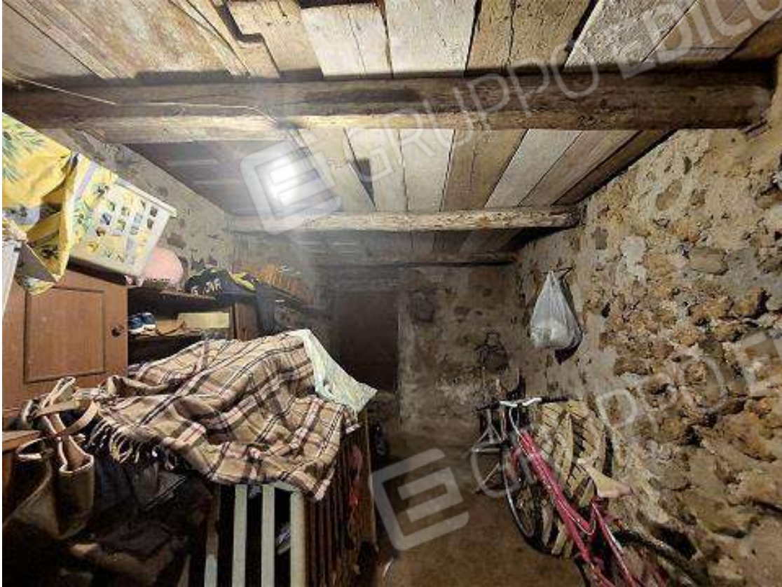
19 = Magazzino di P.T. – vano D (vista verso porta su via Lucania)
