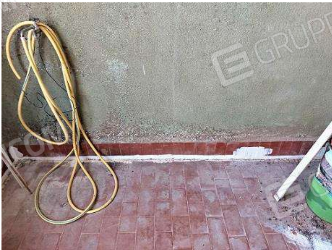
90 = Abitazione di 3°P – vano S (part. della pavimentazione)
