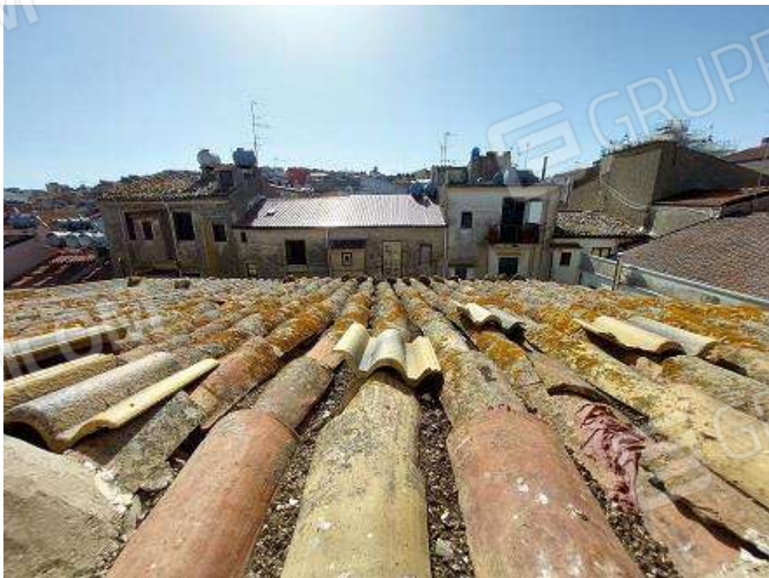
78 = Abitazione di 3°P – vano Q (vista dalla finestra sul tetto dei vani O e P del secondo piano)
