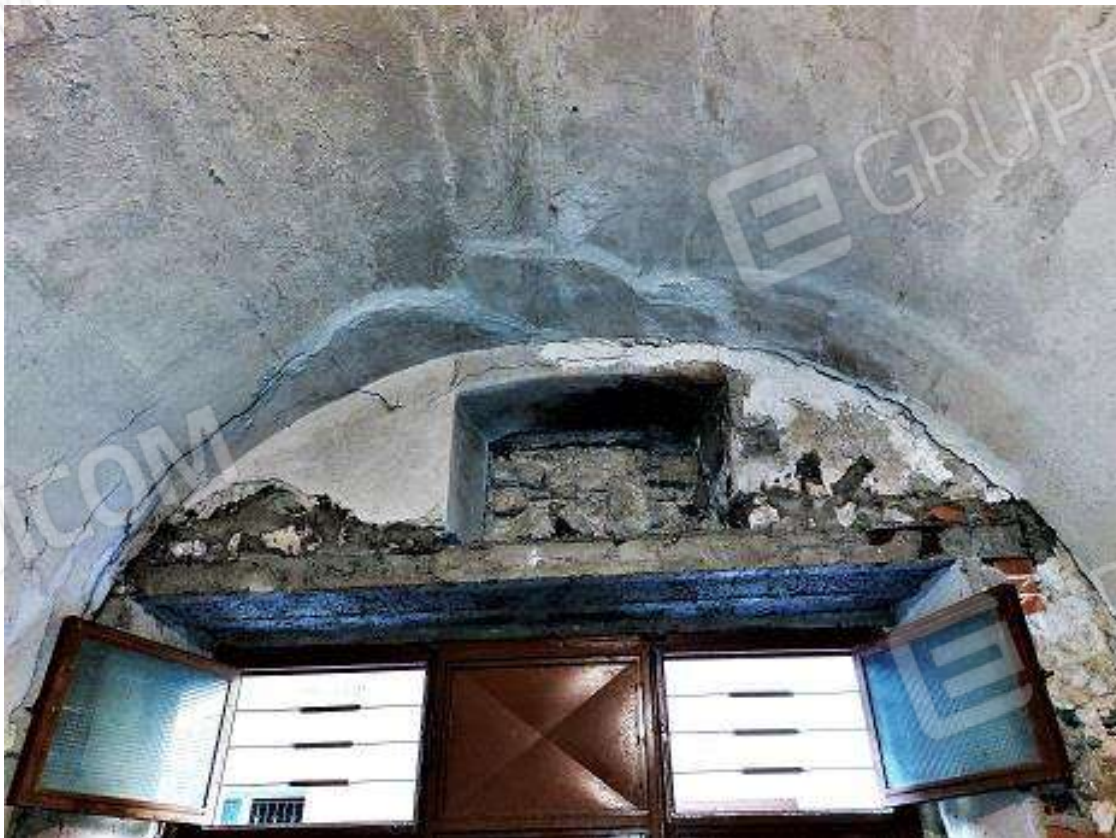
28 = Magazzino di P.T. – vano E (part. architrave)
