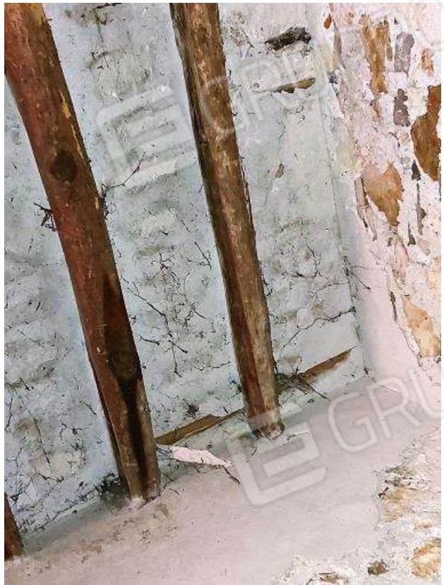
16 = Magazzino di P.T. – vano C (part. del solaio)
