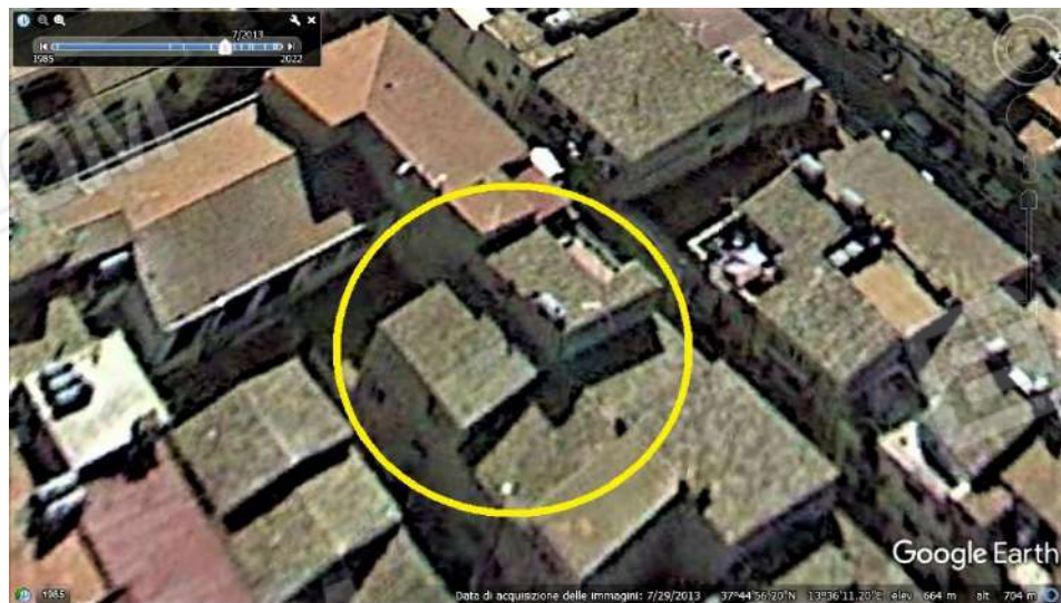
Immagine satellitare 29.07.2013 (vista da Sud-Est lato Via Lucania)
