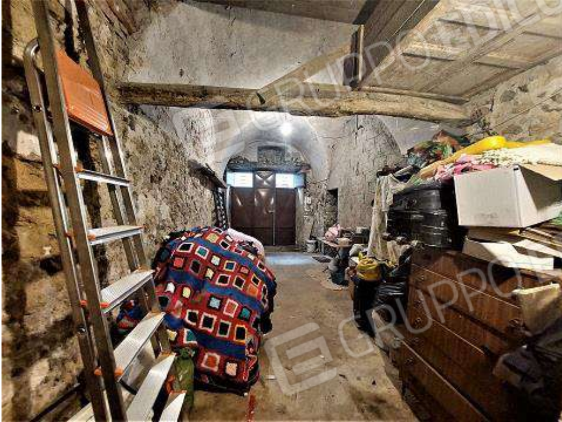
27 = Magazzino di P.T. – vano D (vista verso vano E prospiciente la via Maria SS. Dell’Aiuto)
