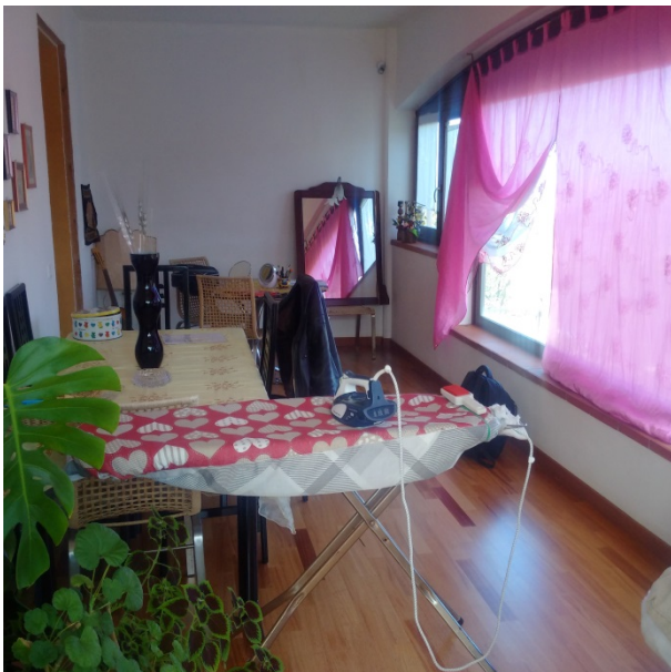
Foto n. 4 - Loggiato verandato sul lato nord trasformato in vano abitabile attraverso la chiusura delle aperture ad arco tramite infissi.
