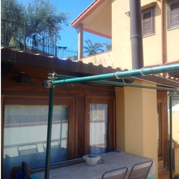
Foto n. 3 - Terrazza sul lato ovest della scala di accesso piano S1 dell'abitazione
