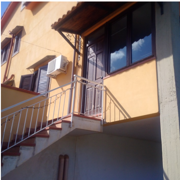
Foto n. 2 - Scala che conduce al piano S1 dell'abitazione
