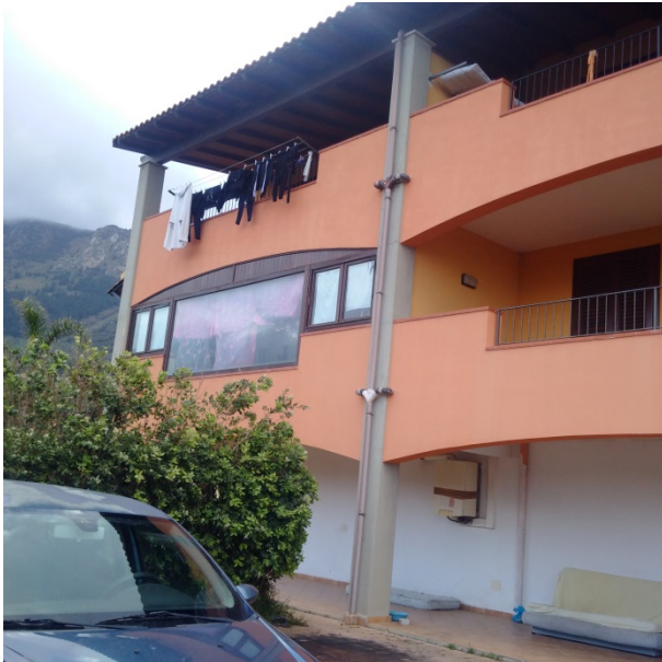
Foto n. 1 - Esterno con portico
