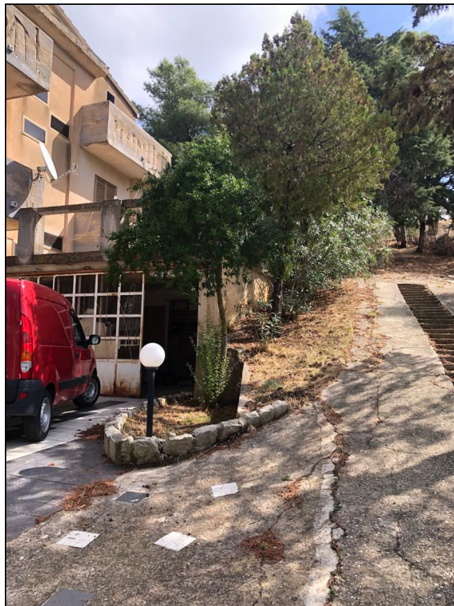
Foto 2/3 - ripresa del compendio in Baucina -C/da Rini - Fg 11 - p.Ila 1134 - Comune di Baucina
