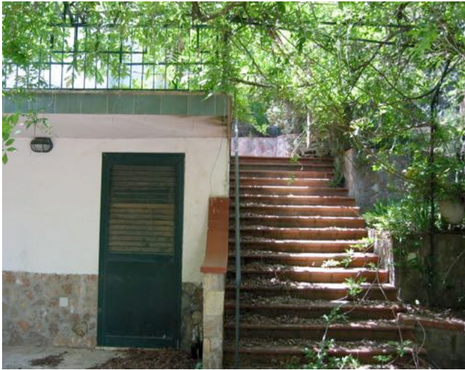
SCALA PRINCIPALE DA INGRESSO AL PIANO TERRA SUB 8
