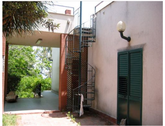
ZONA ARRIVO DA INGRESSO ED ACCESSO AL SUB 8 E SCALA ELICOIDALE PER ACCESSO COPERTURA
