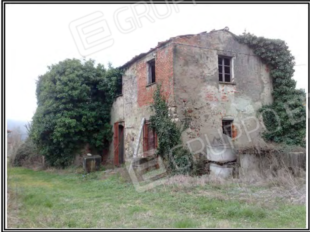
Foto n. 5 – Fabbricato rurale mappale 42
