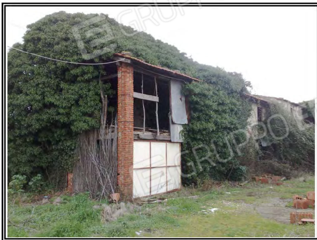
Foto n. 9 – Fabbricato rurale mappale 42 – Fabb. Verso mare
