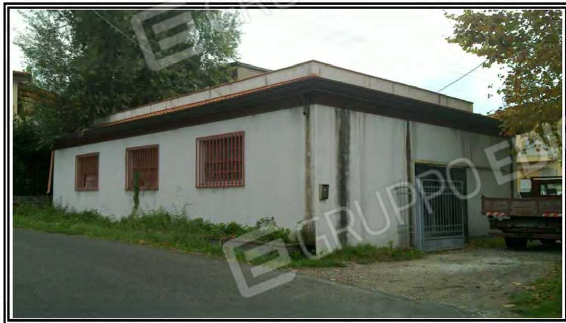
Foto n. 1 – Vista del fabbricato dalla strada
