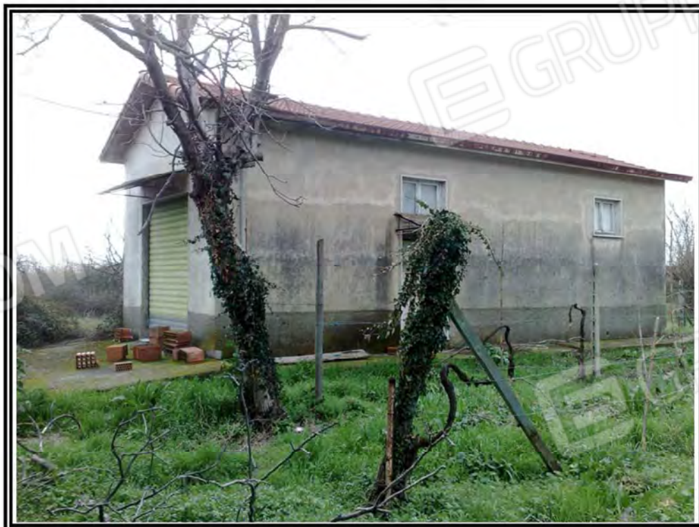
Foto n. 12 – Fabbricato rurale mappale 311
