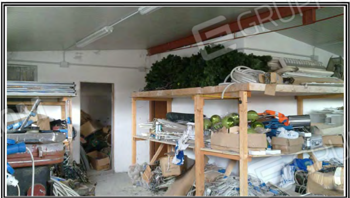
Foto n. 4 – Vista interna del corpo in ampliamento
