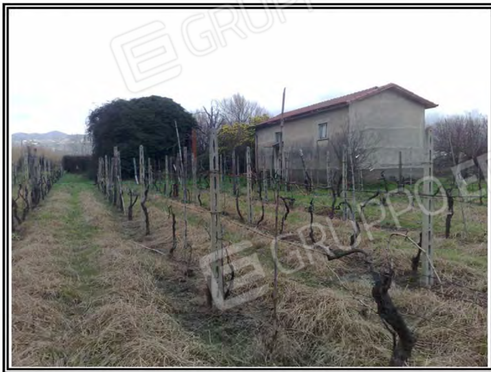
Foto n. 11 – Fabbricati rurali mappali 42 e 311
