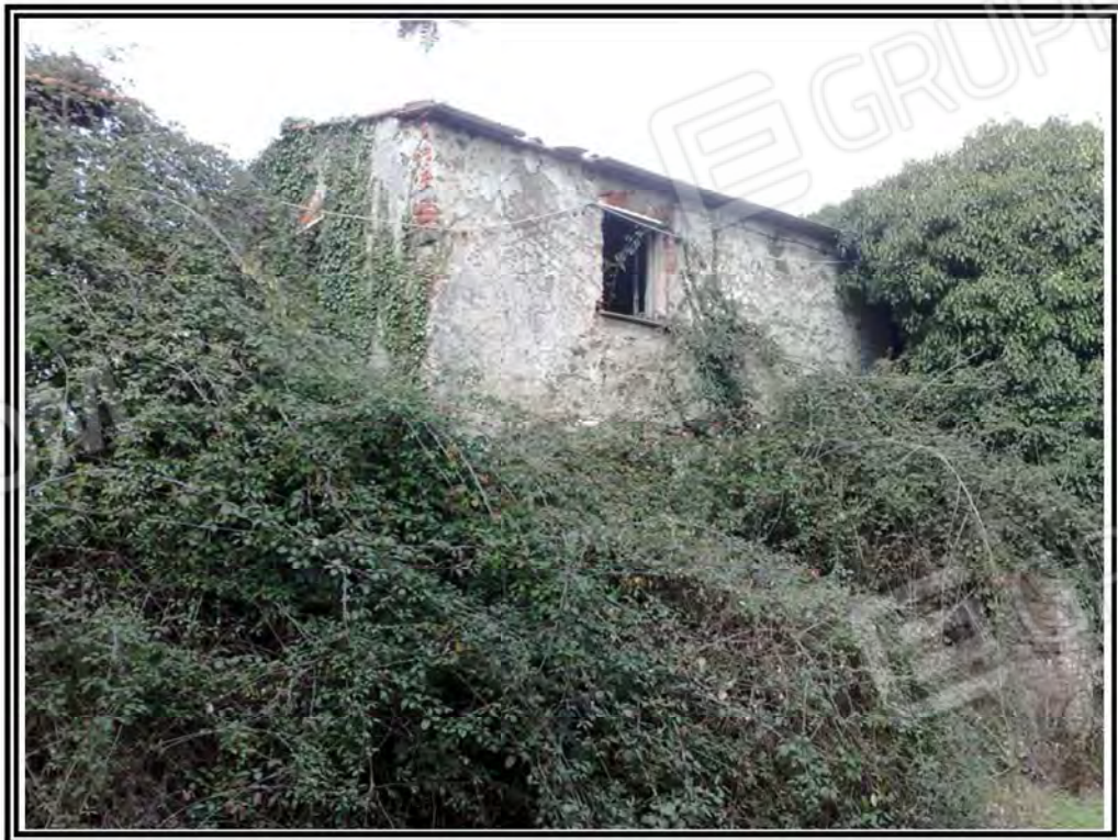
Foto n. 6 – Fabbricato rurale mappale 42
