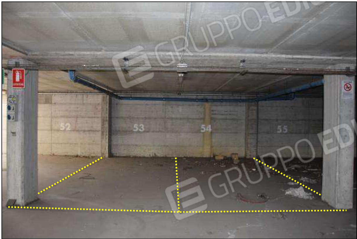
FOTO 1 – SUB 57 (POSTO 53) / SUB 58 (POSTO 54)
