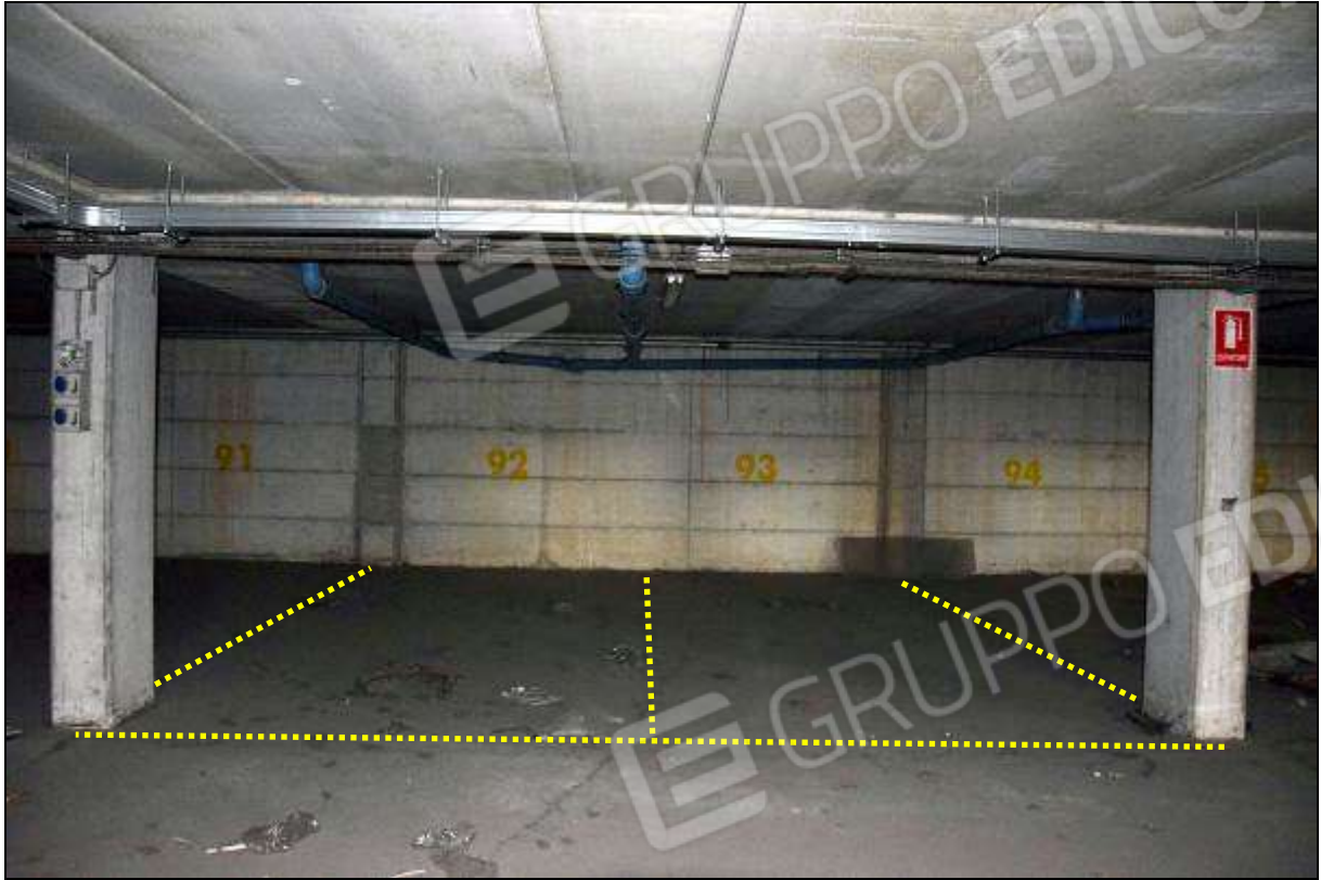
FOTO 7 – SUB 79 (POSTO 92) / SUB 80 (POSTO 93)
