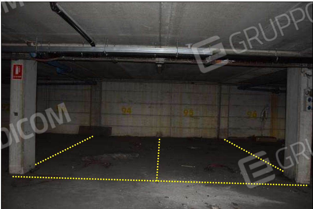
FOTO 8 – SUB 81 (POSTO 94) / SUB 82 (POSTO 95)
