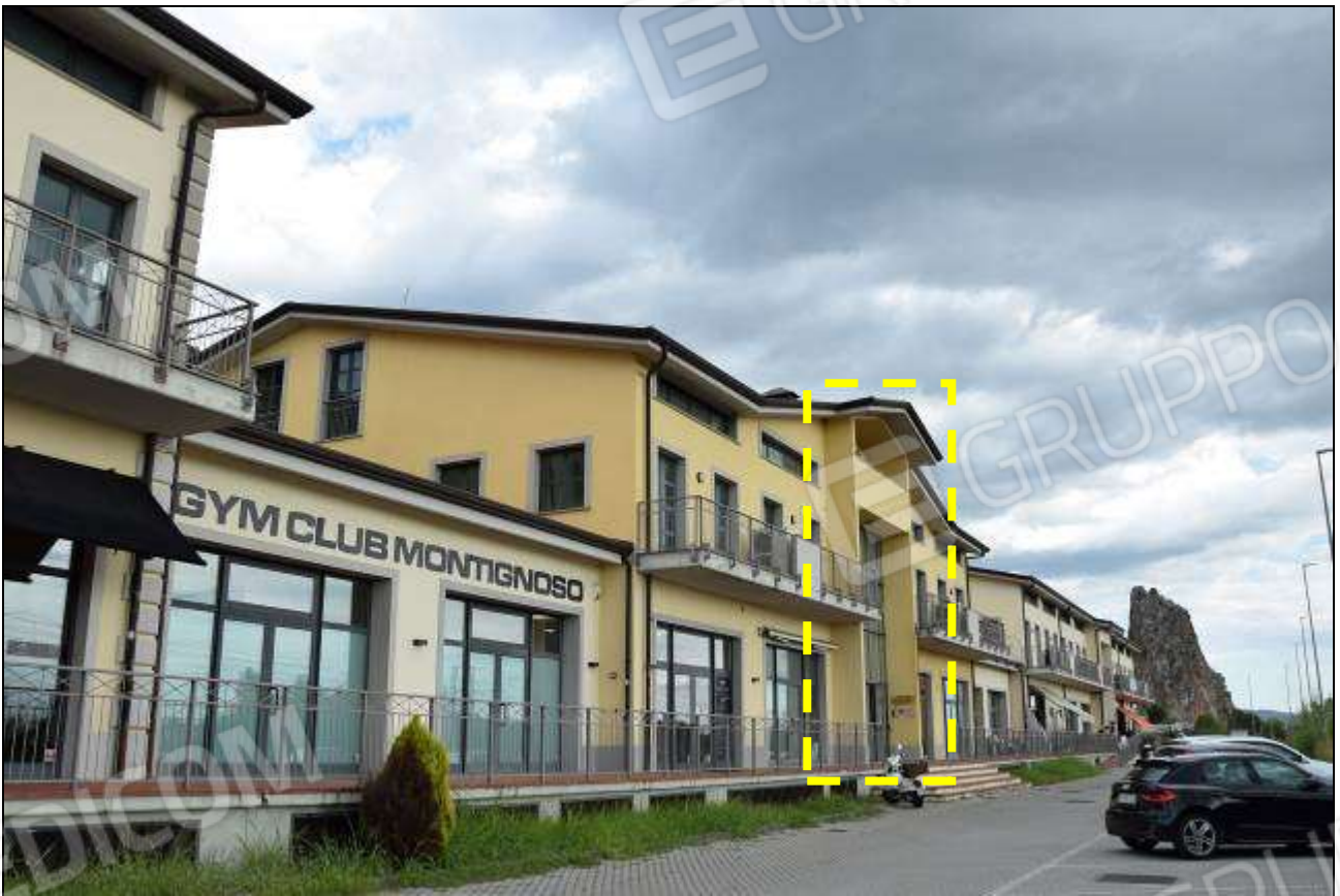
INDIVIDUAZIONE ACCESSO VANO SCALA “B” (BLOCCO CENTRALE)
