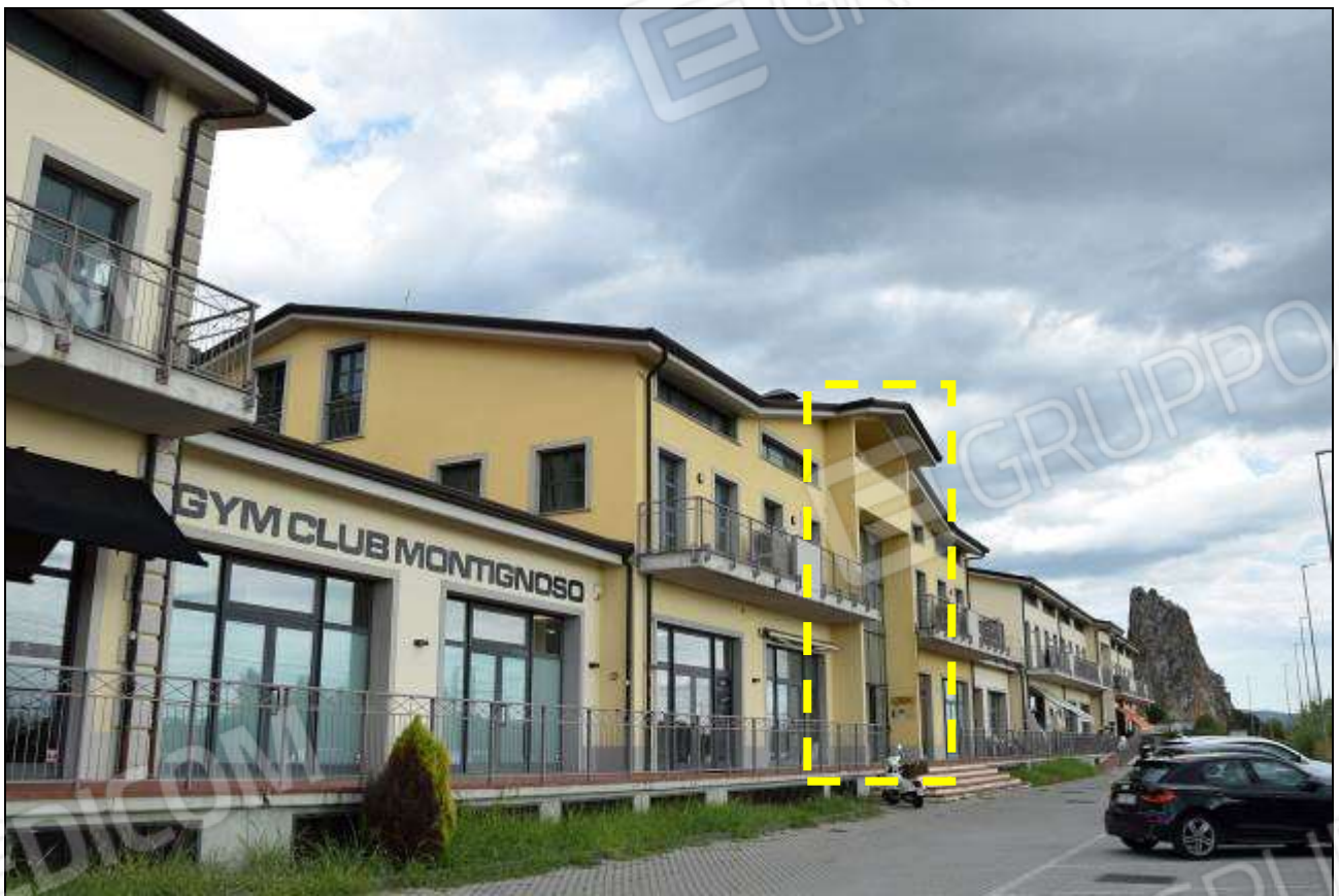
INDIVIDUAZIONE ACCESSO VANO SCALA “B” (BLOCCO CENTRALE)
