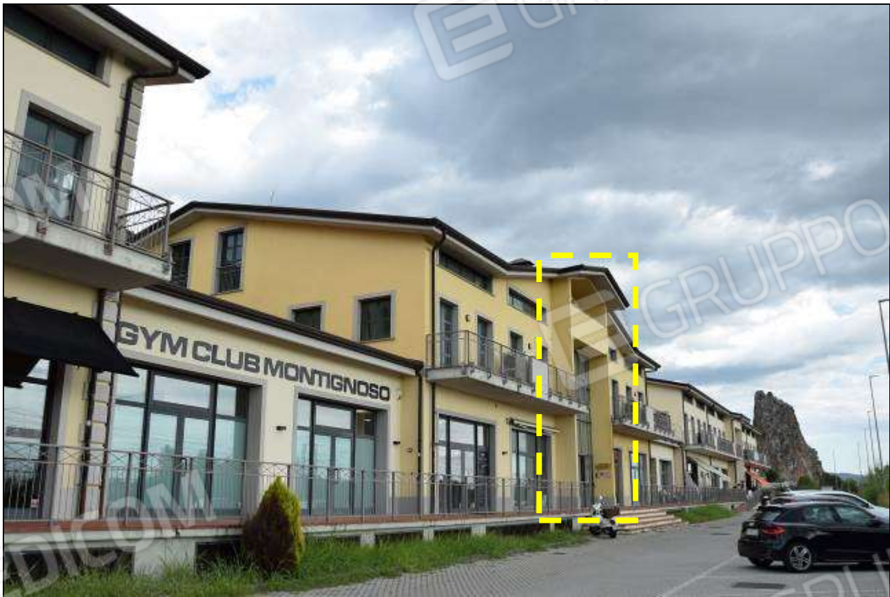
INDIVIDUAZIONE ACCESSO VANO SCALA “B” (BLOCCO CENTRALE)
