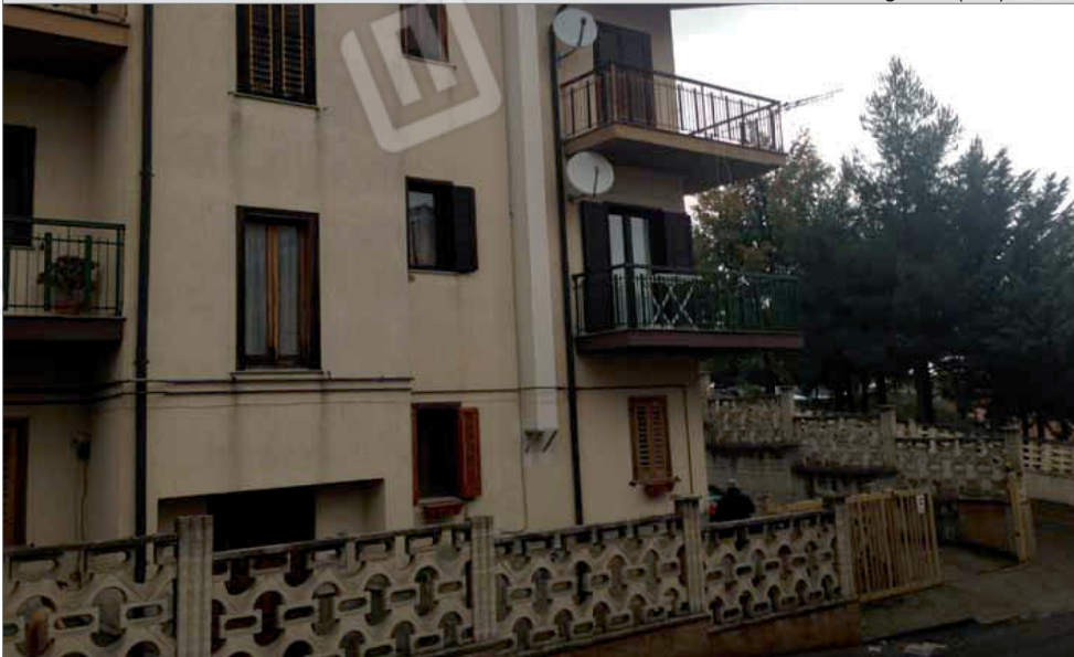
PERIZIA DI STIMA R.G.E. N°201/12 - PROSPETTO ESTERNO - VISTA ESTERNA PORTONE INGRESSO ALLOGGI - Edificio residenziale in via Pennetti n°2 in Comune di Stigliano (MT)
