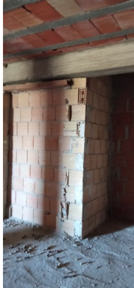
Piano primo, particolare ingresso vano scala chiuso
