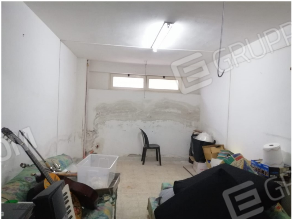
Foto n. 10 – interno ripostiglio al piano seminterrato
