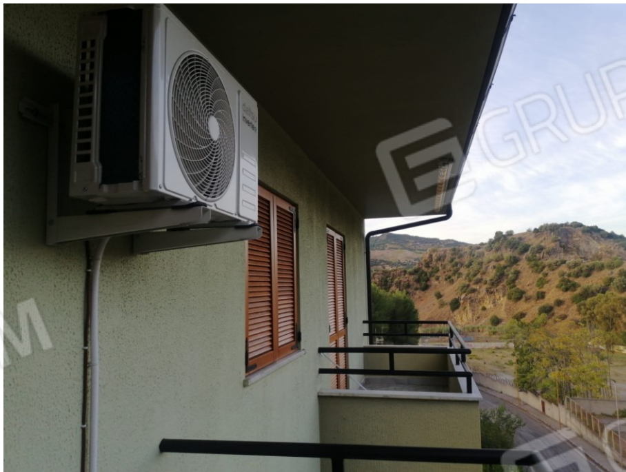
Foto n. 4 – particolare balcone su prospetto posteriore
