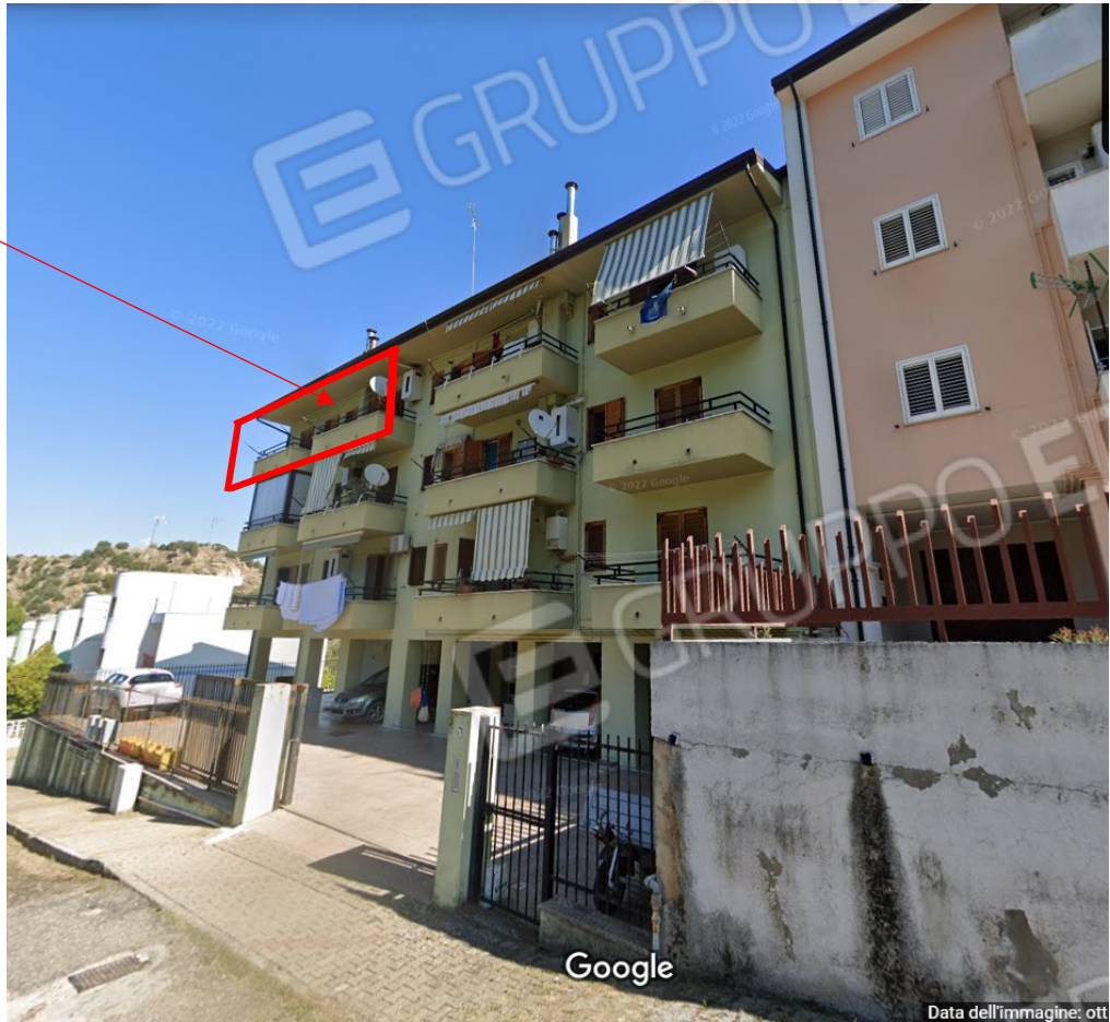
Foto n. 1 – prospetto principale viale della Pineta
