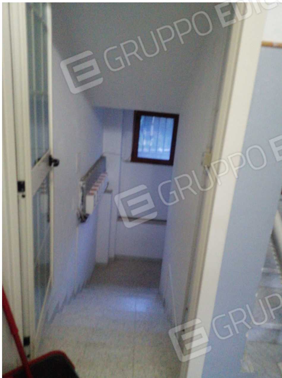
Foto n. 6 – vano scala condominiale
