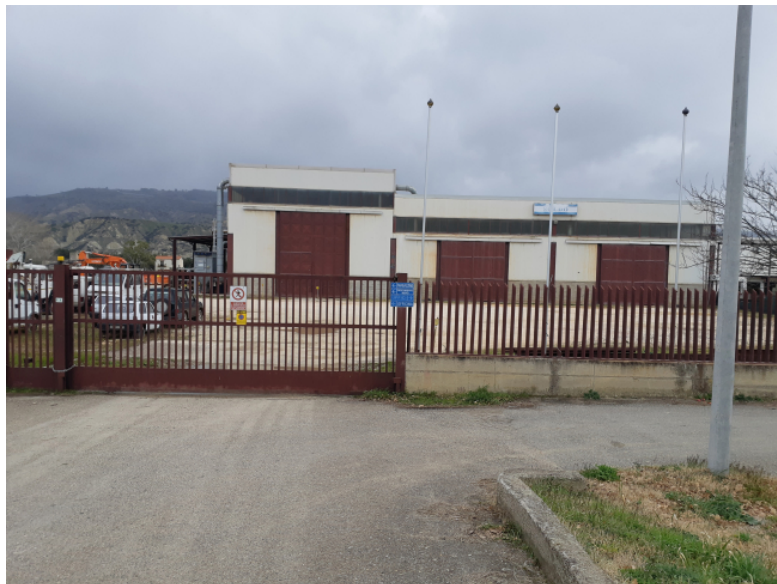
Esterno, ingresso all'opificio
