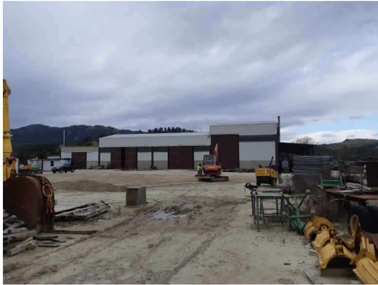
Esterno, prospetto posteriore
