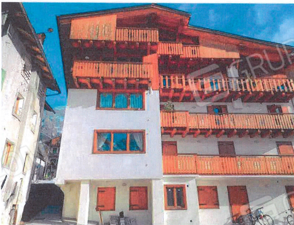
Foto n. 2 : C.F. Fg. 32 mapp. 212 - Prospetto sud
