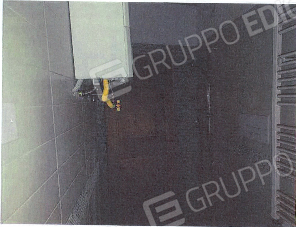
Foto n. 7 : C.F. Fg. 32 mapp. 212 sub 9 - Unità immobiliare al grezzo
