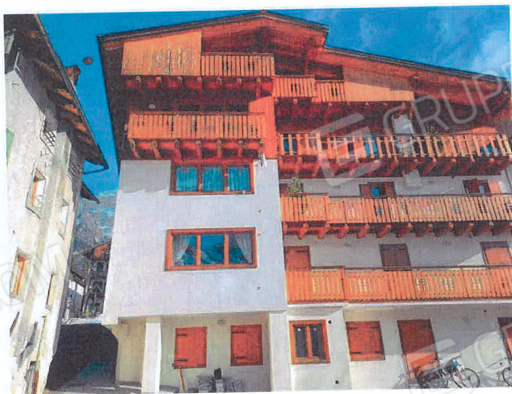
Foto n. 2 : C.F. Fg. 32 mapp. 212 - Prospetto sud
